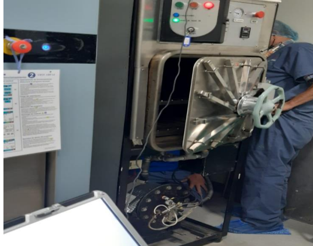
Ilustración 24: Revisando esterilizadora a vapor AMSCO
