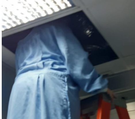
Ilustración 14: Supervisión de la instalación del cableado requerido para polígrafo
