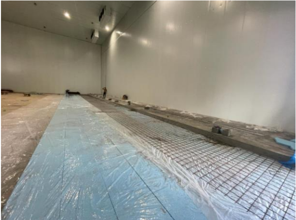
Ilustración 27-Revisión de áreas por fundir
