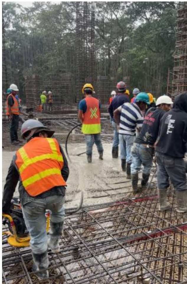
Ilustración 34-Colado con bomba
