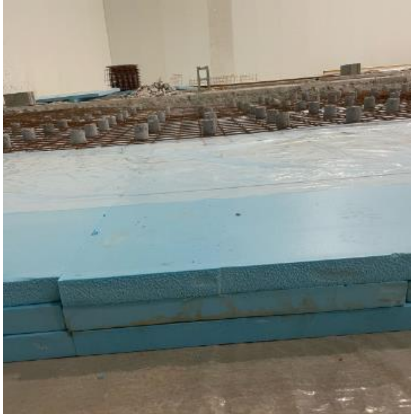
Ilustración 32-Aislante térmico para losa de piso
