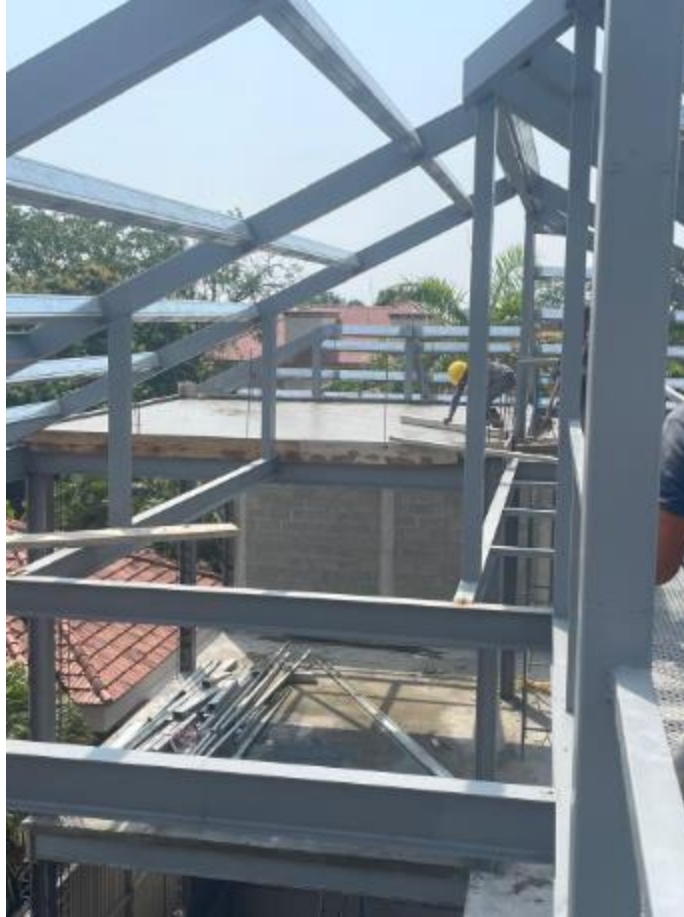
Ilustración 64-Losa #2 para condensadores
