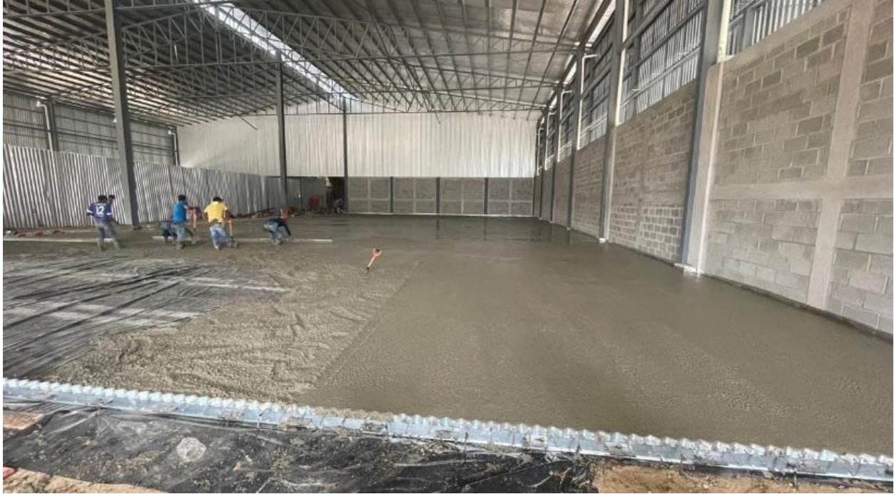
Ilustración 66-800 m 2 de fundición de losa de piso
