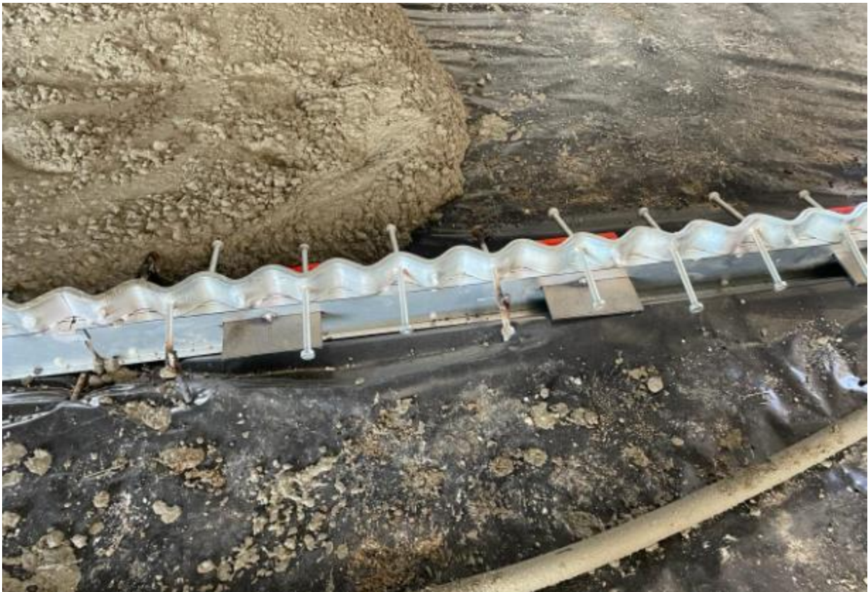
Ilustración 22-Junta S instalada
