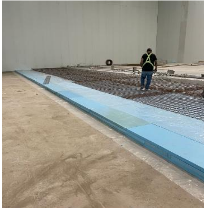
Ilustración 33-Capas de losa para cuarto frío
