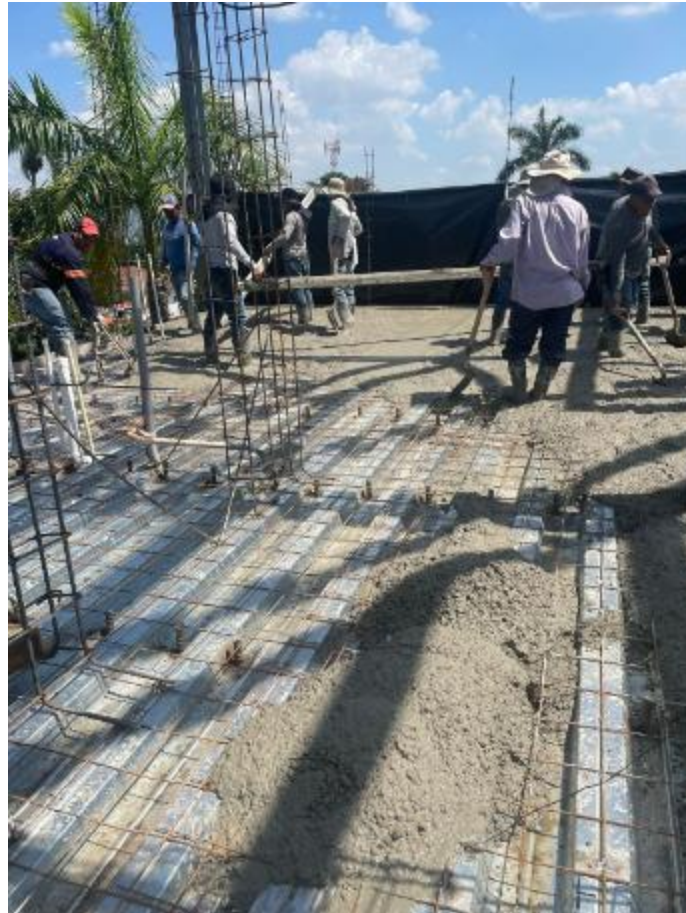
Ilustración 42-Sistema lamina losa acero
