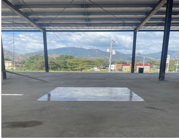
Ilustración 5-Acabado final de la muestra
