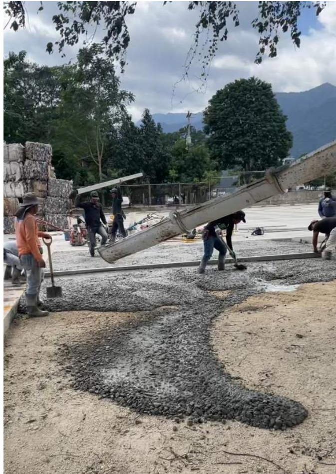
Ilustración 16-Descarga Directa
