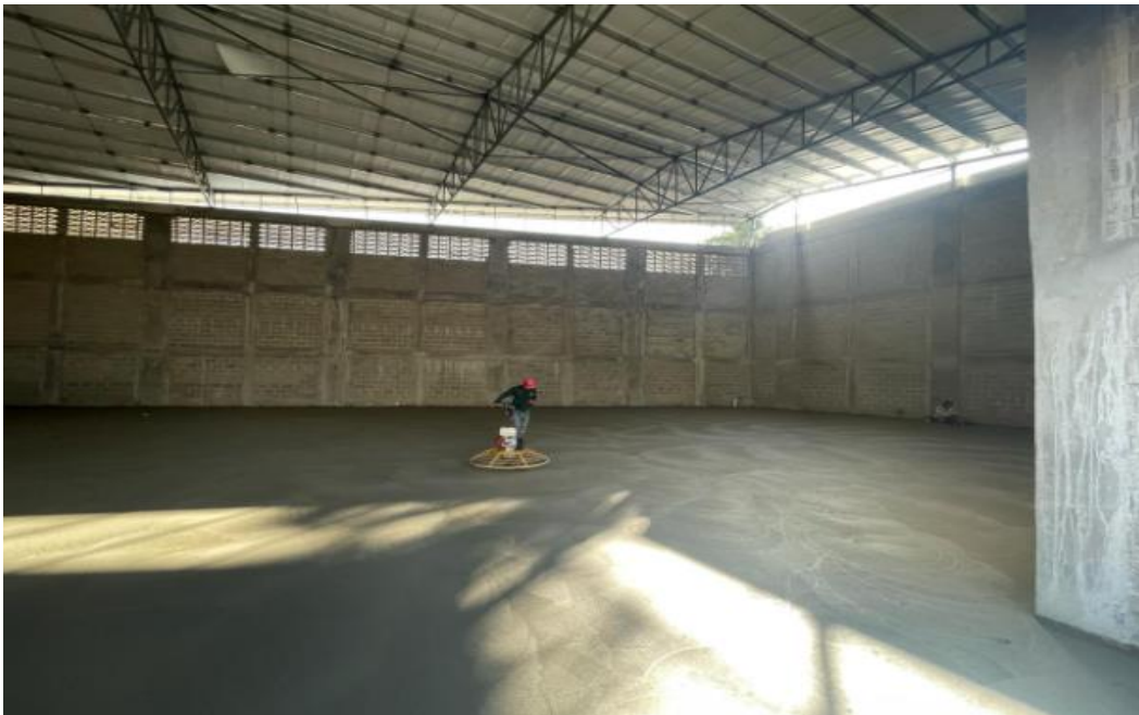
Ilustración 28-Acabado final Allanado liso
