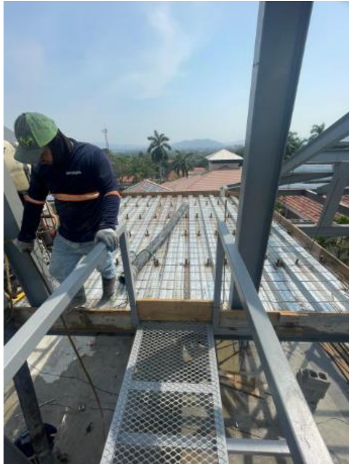
Ilustración 63-Losa #1 para condensadores
