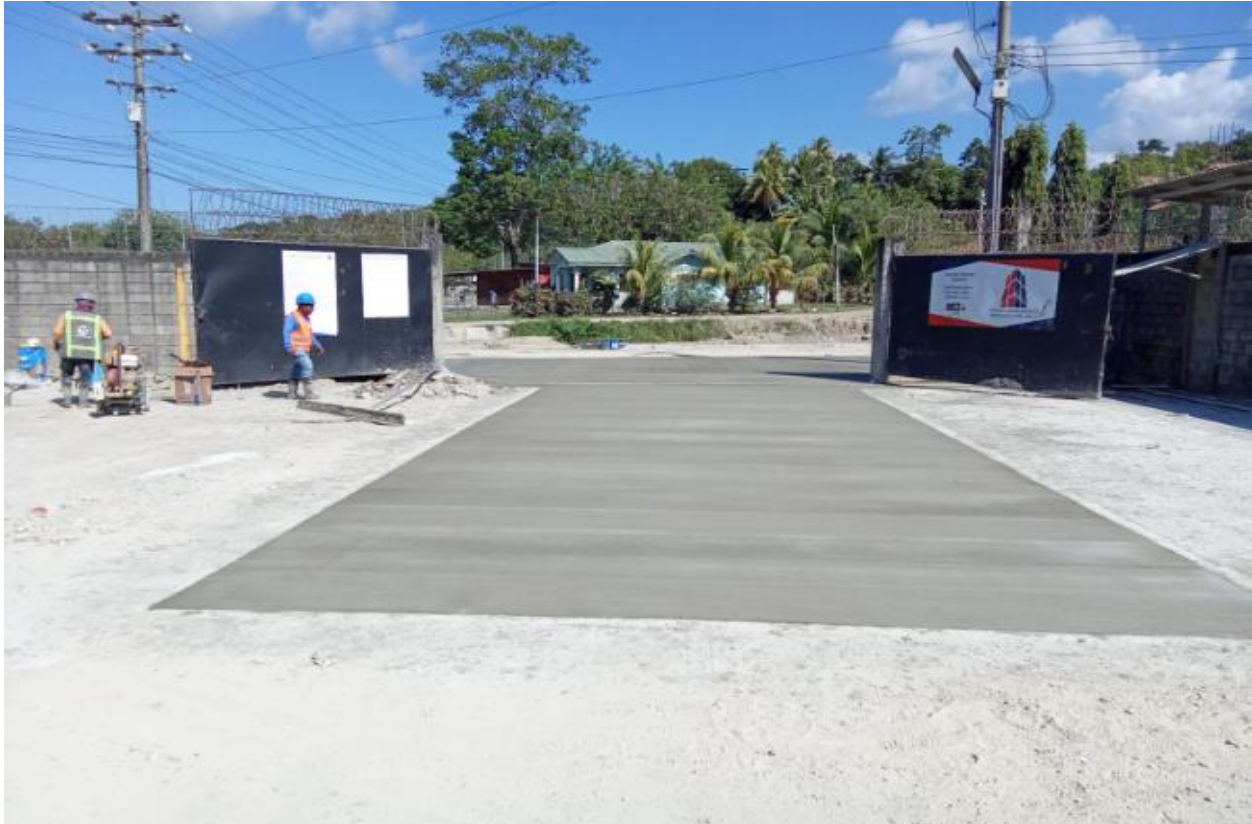
Ilustración 31-Ultima fundición de etapa II
