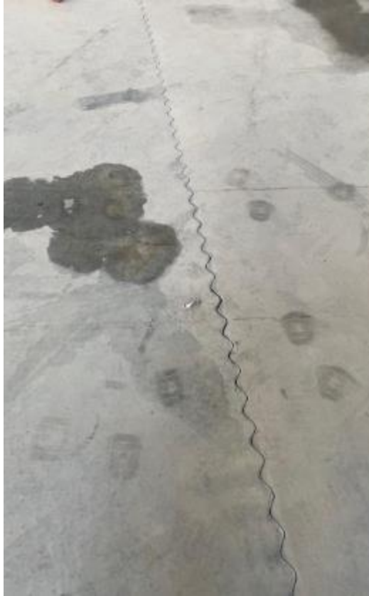
Ilustración 73-Junta metálica tipo S en funcionamiento
