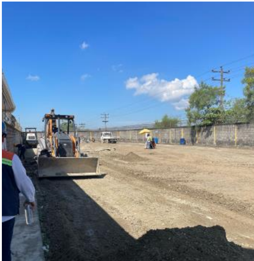
Ilustración 11-Nivelación de terreno
