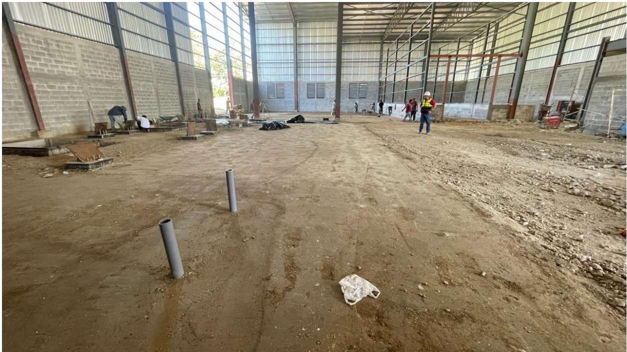
Ilustración 19-Área compactada
