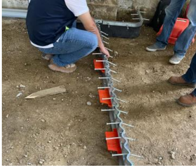
Ilustración 20-Junta Metálica Tipo S
