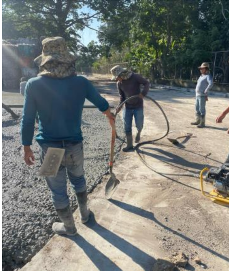
Ilustración 8-Vibrado del concreto
