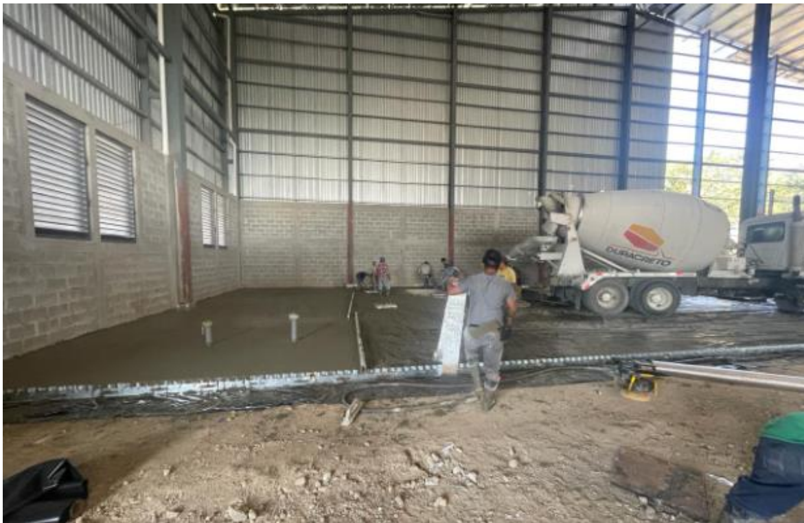
Ilustración 21-Colado descarga directa
