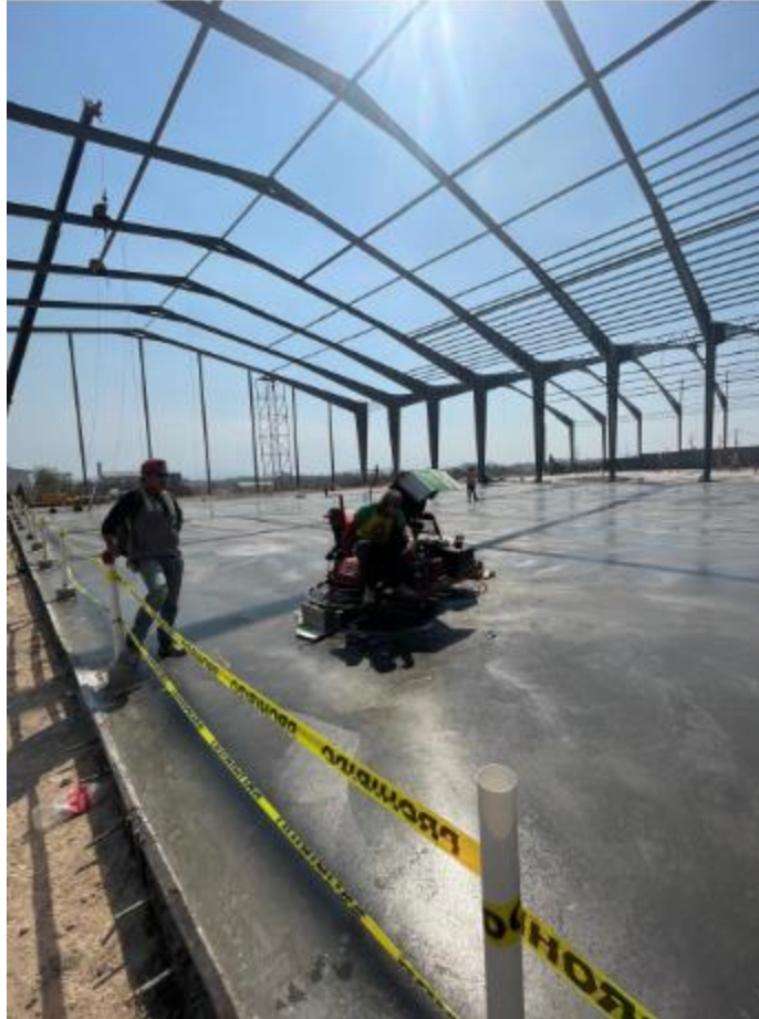
Ilustración 52-Losa con acabados terminados
