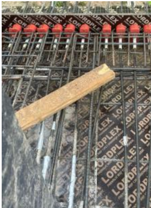
Ilustración 40-Salida de cables de refuerzo
