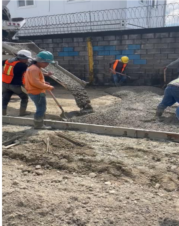
Ilustración 12-Descarga de concreto
