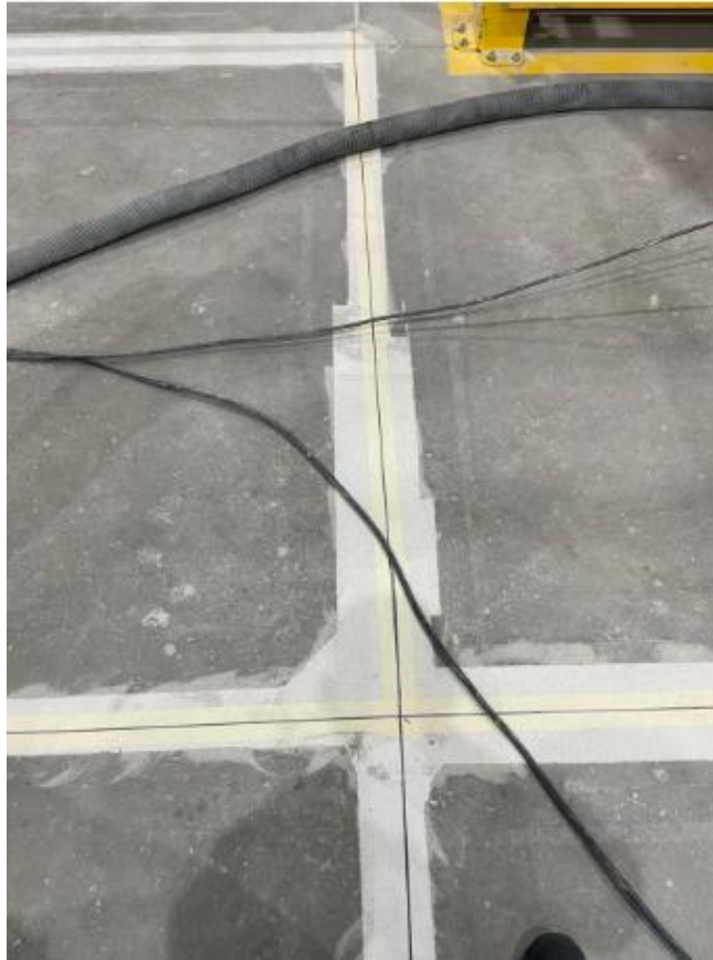
Ilustración 58-Reparaciones en juntas
