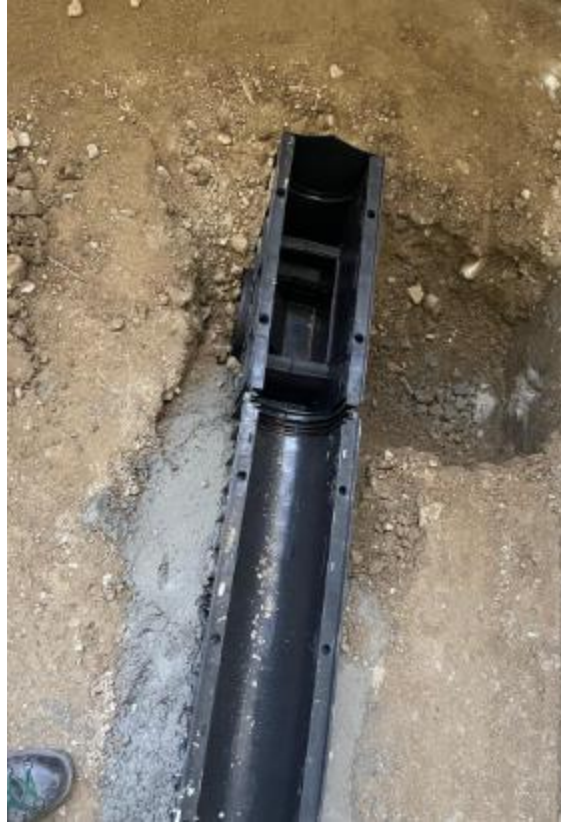
Ilustración 71-Instalación de drenaje prefabricado
