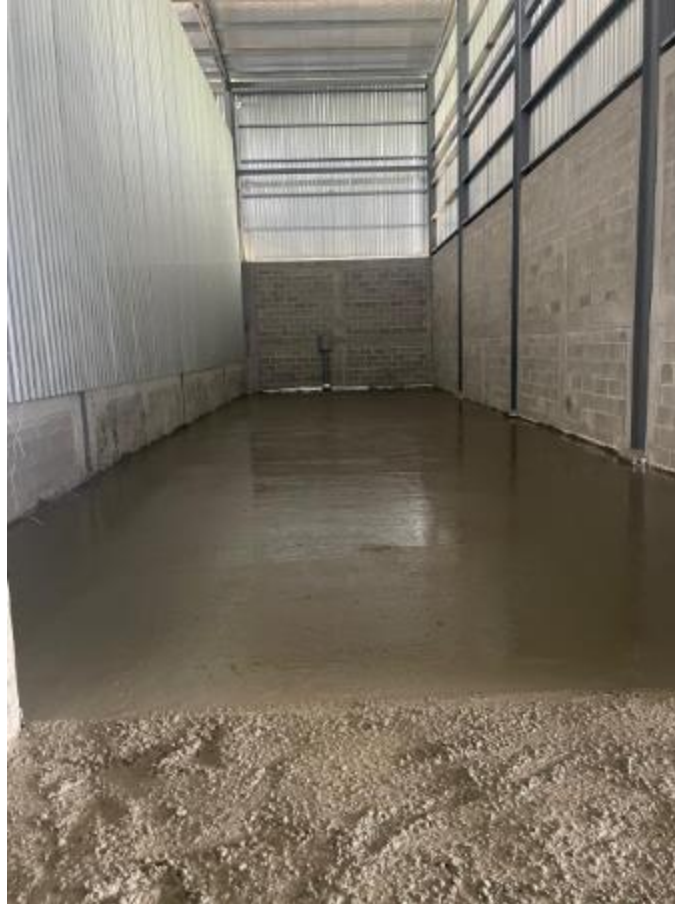
Ilustración 56-Cuarto de producto terminado
