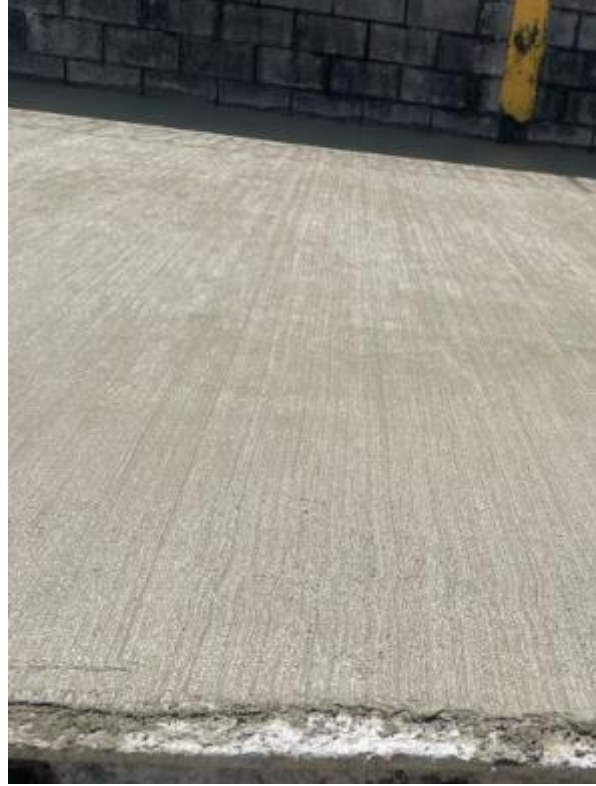
Ilustración 15-Escobillado fino
