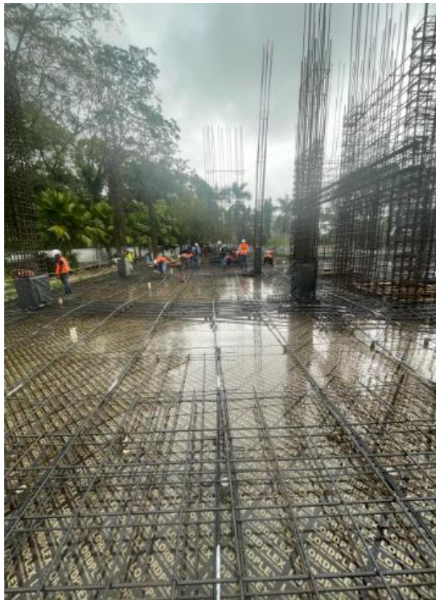
Ilustración 35-Armado estructural de losa post tensada
