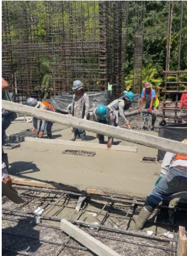
Ilustración 39- Colocación y nivelado entrepiso 2
