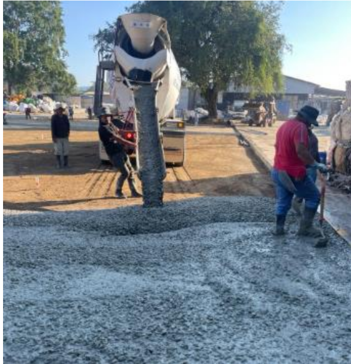
Ilustración 7-vertido del concreto
