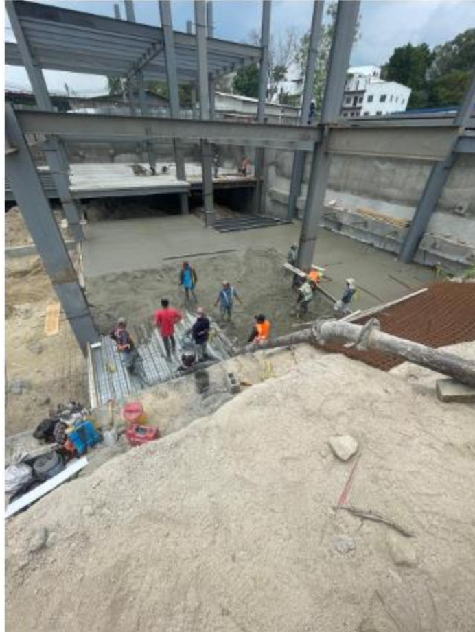
Ilustración 62-Losa sótano de parqueo
