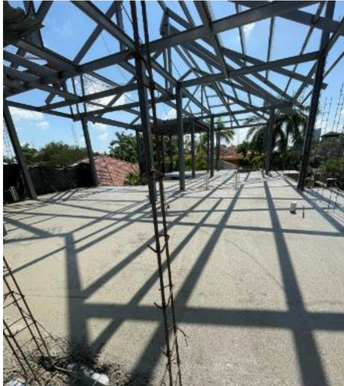
Ilustración 43-Colocación de concreto terminada
