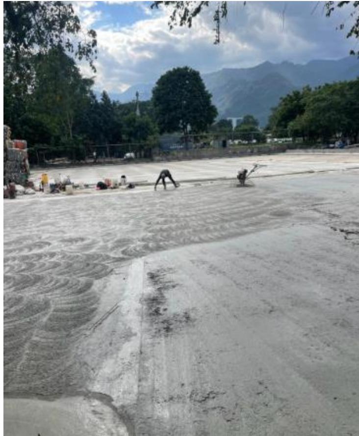
Ilustración 17-Remolineado Fino
