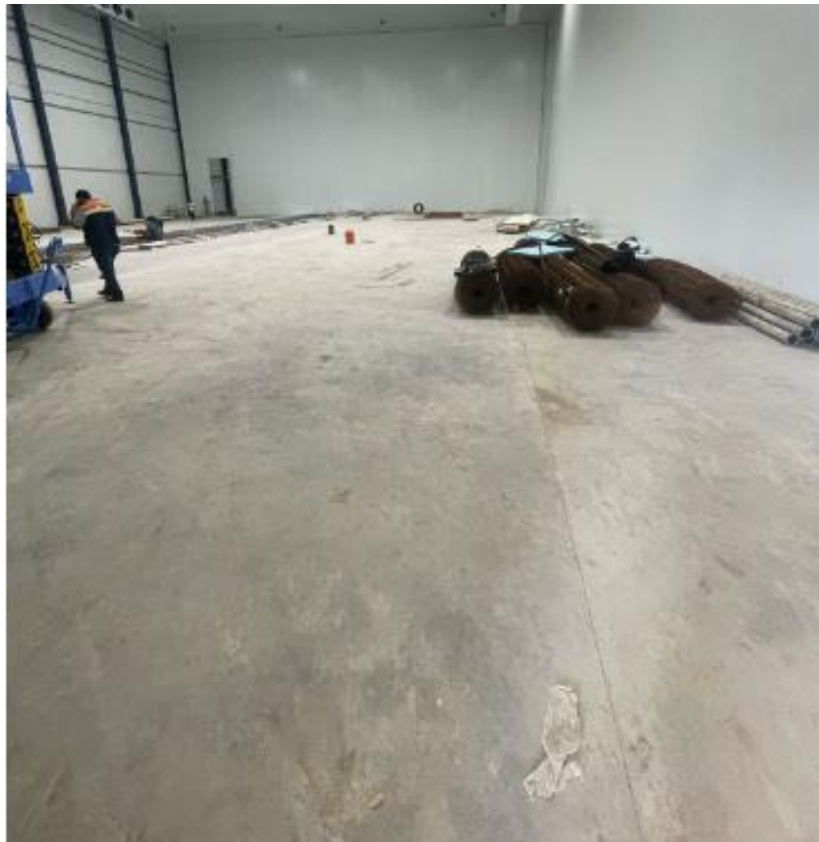
Ilustración 38-80% de piso terminado
