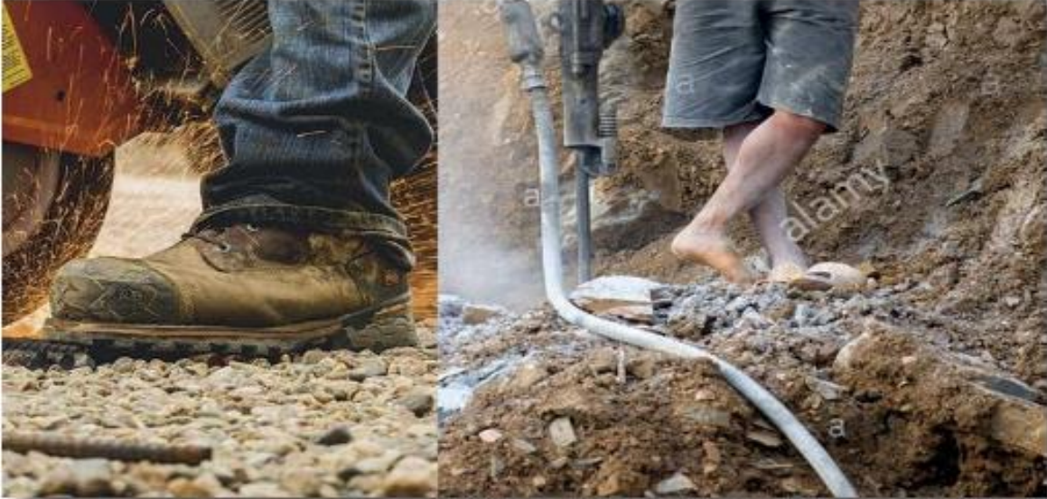
Imagen 7.5 Uso correcto de zapato de construccion
