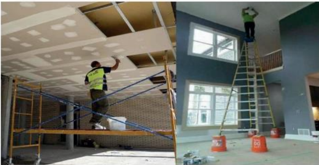
Imagen 7.4 Uso correcto de andamios para trabajo en altura
