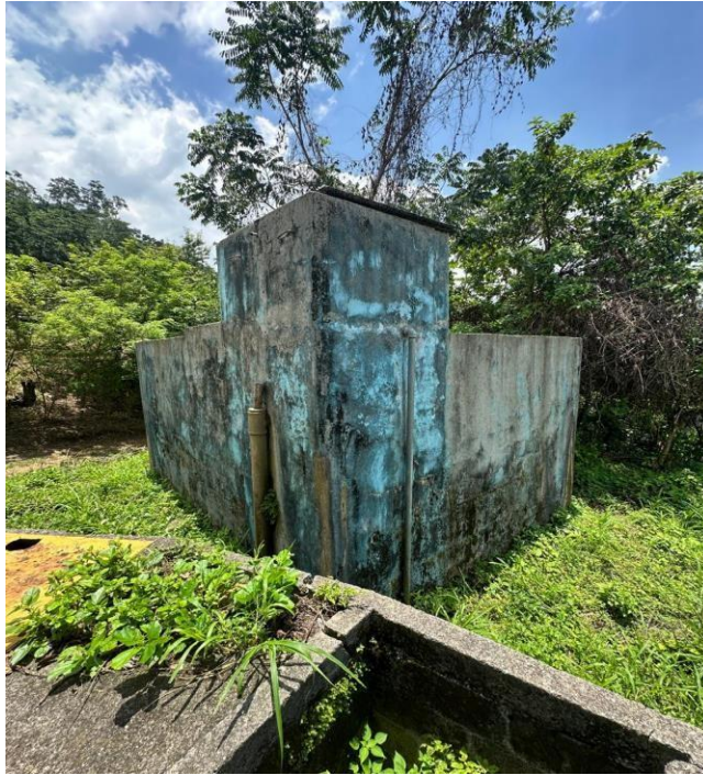
Anexo 1 - Estado actual tanque existente
