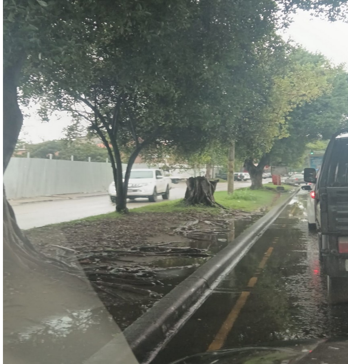
Figura 31. Condiciones de las vías en puntos de entrega zona centro de S.P.S
