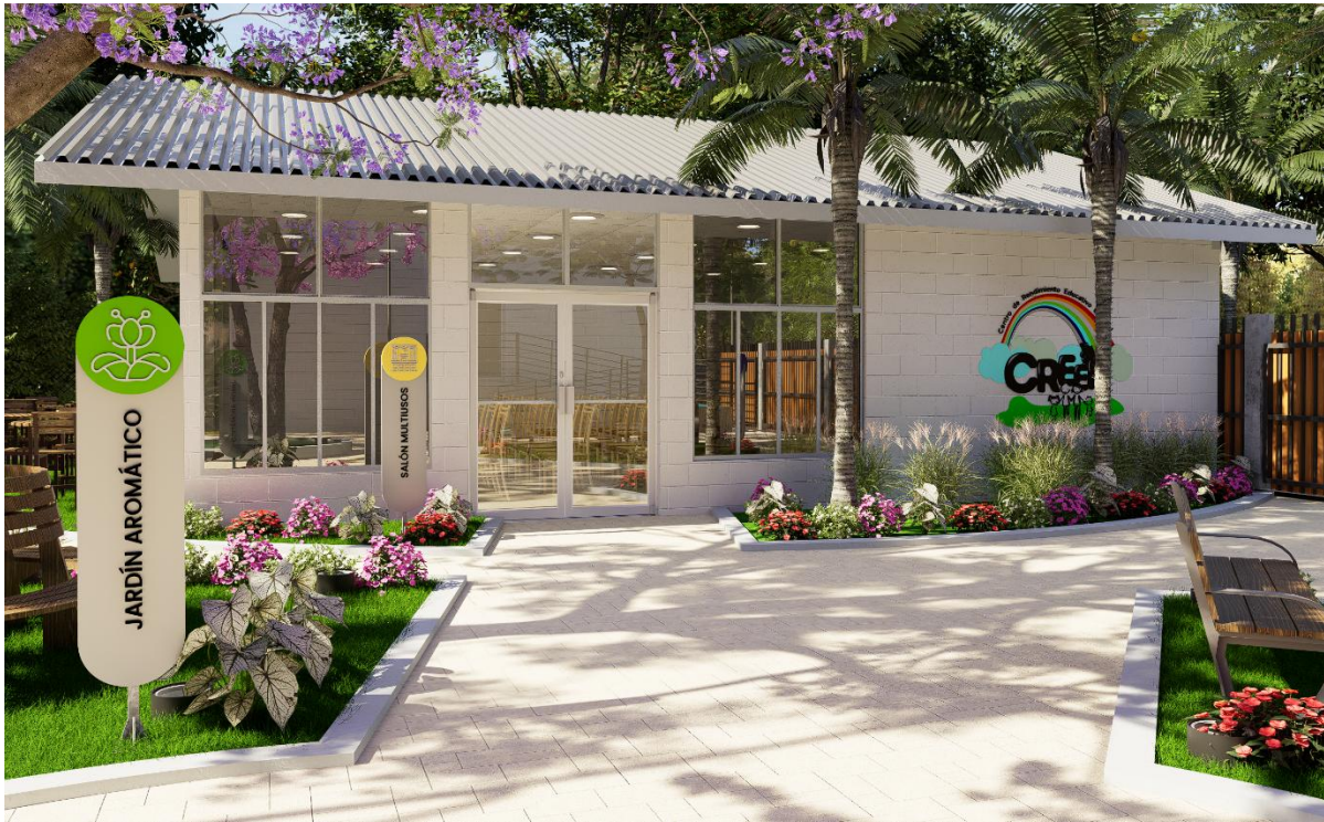
Figura 74. Vista hacia Salón Multiusos
