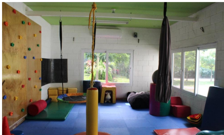
Figura 29. Área Sensorial Climatizada
