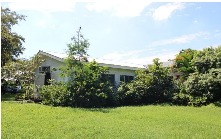
Figura 31. Área Verde al Noreste de la Edificación detrás del Edificio Existente
