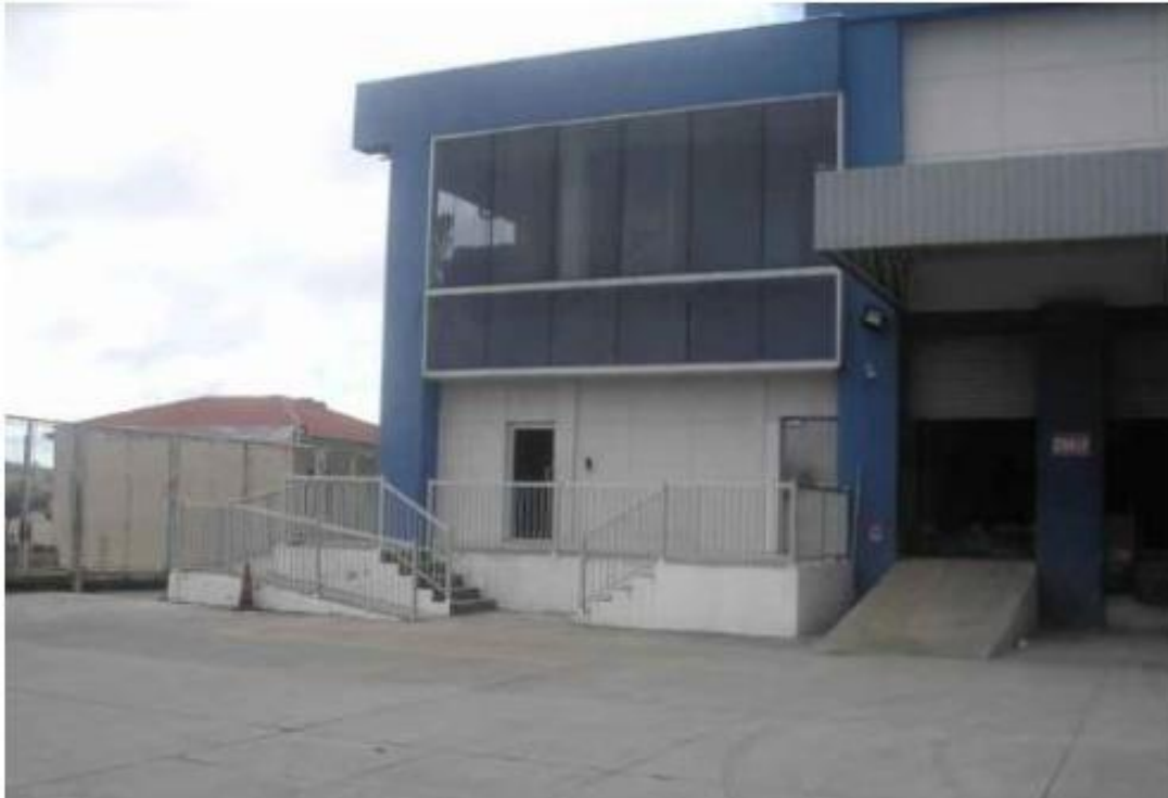
Figura 6. -17 Vista Frontal del Local
