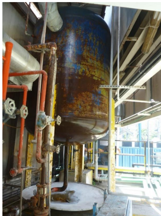
Ilustración 39. Receptor de baja presión EMSULA
