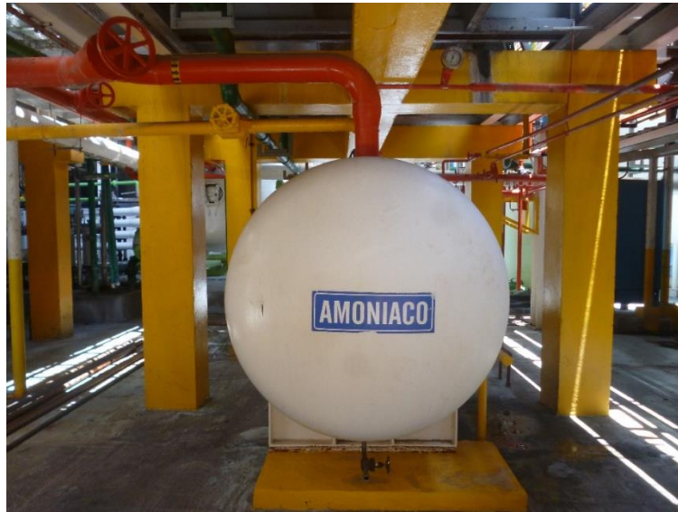
Ilustración 38. Receptor de alta presión EMSULA
