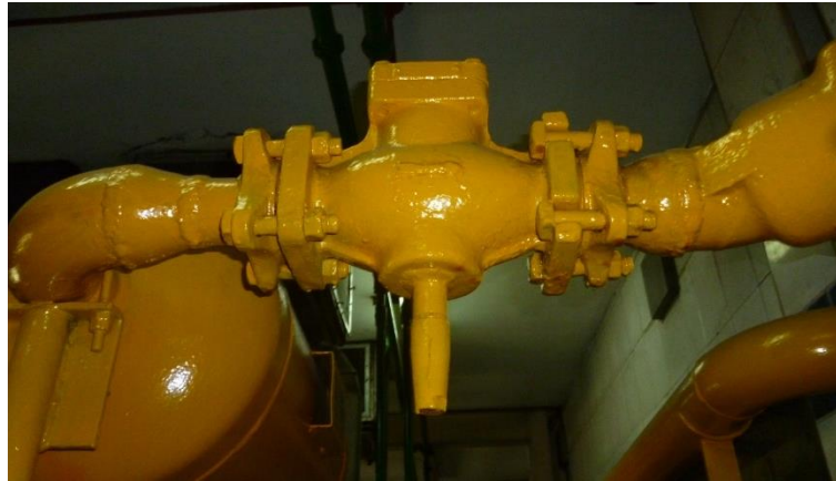
Ilustración 20. Válvula anti retorno industrial
