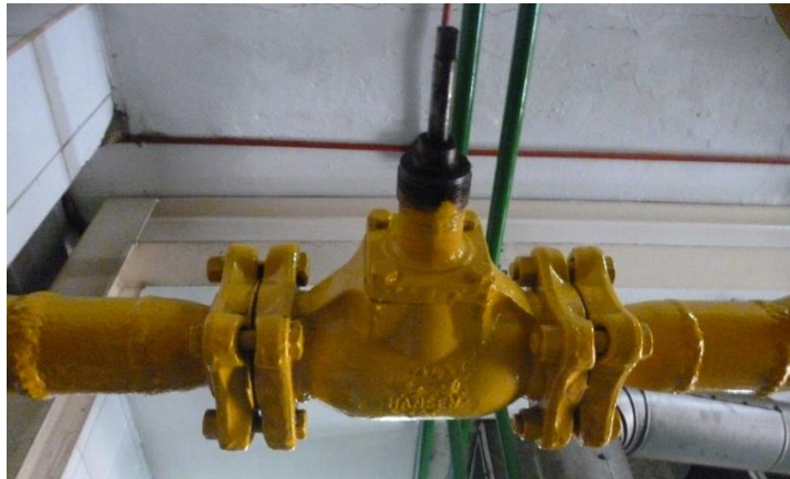
Ilustración 40. Válvula Antirretorno de gravedad
