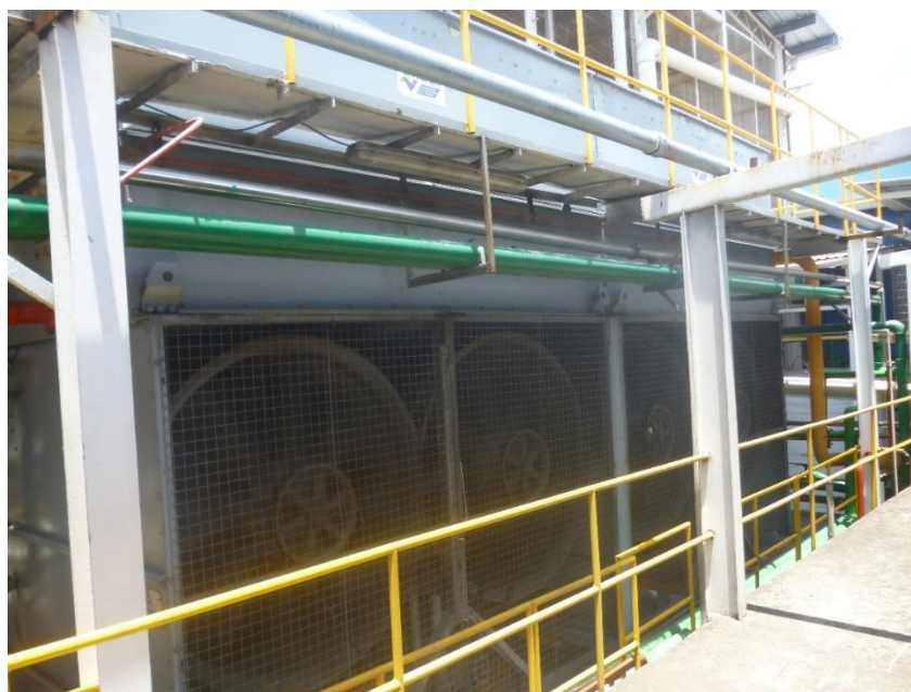
Ilustración 14. Condensador Industrial
