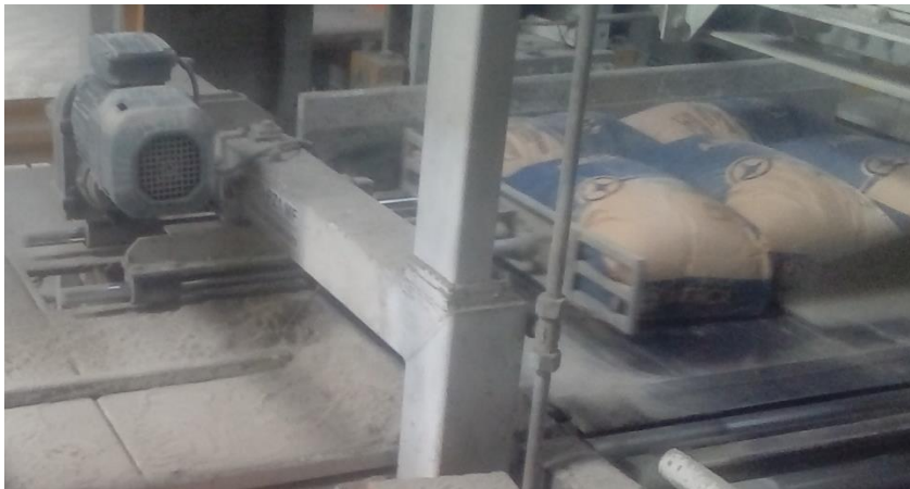
Ilustración 35. Exceso de cemento acumulado en POLIMAT C40.
