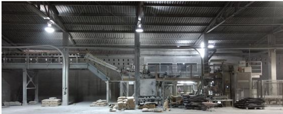
Ilustración 26. Bodega de almacenamiento y carga 2 con iluminación eléctrica encendida.
