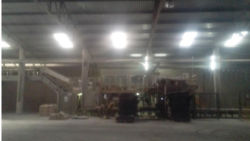
Ilustración 27. Bodega de almacenamiento y carga 2 con láminas traslucidas instaladas en techado.
