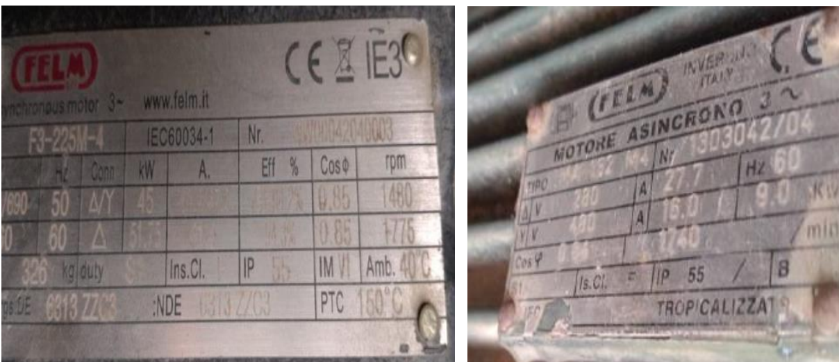
Figura 19. Bombas de agua FELM 51.75KW y 9KW.
