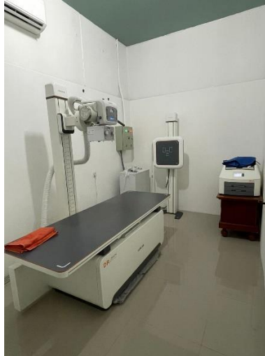
Ilustración 41. Instalación del equipo de Rayos X.
