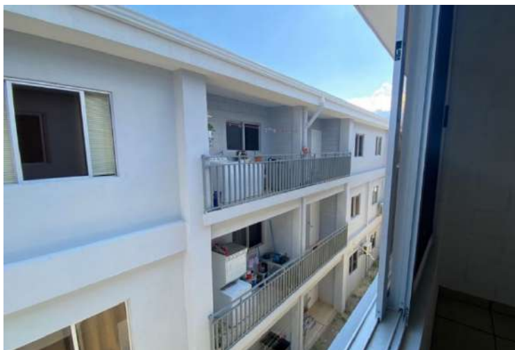
Figura 54 Espacios generales condominio Hábitat de la Cordillera
