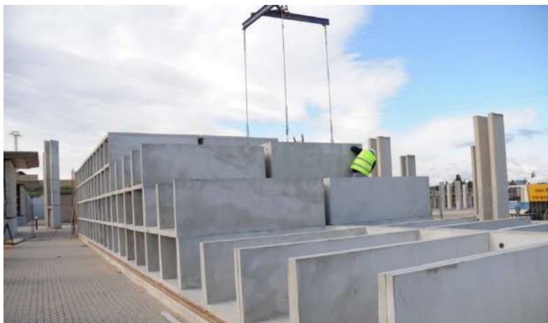
Figura 25 Construcción con elementos prefabricados
