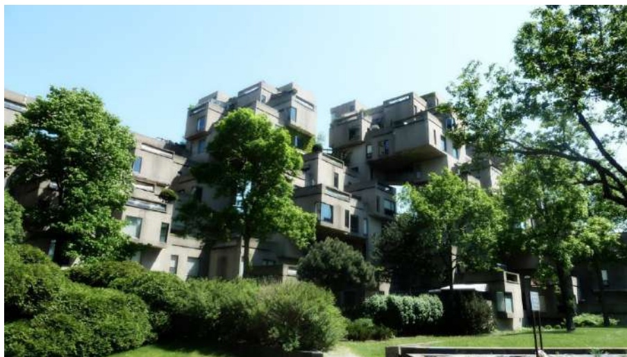
Figura 26 Edificio residencial Habitat 67, Montreal
