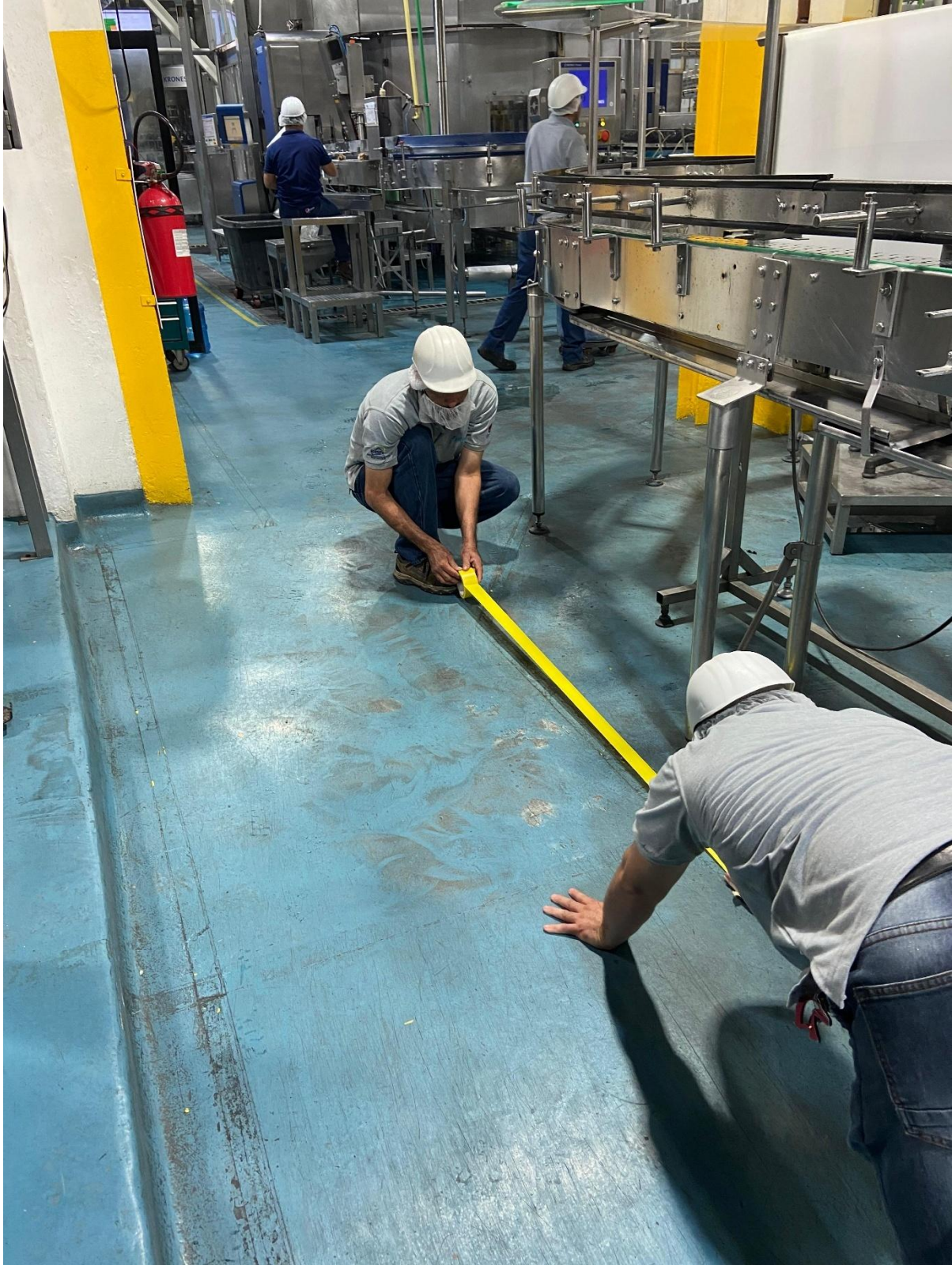
Anexos 18 Instalación de líneas de delimitación de seguridad
