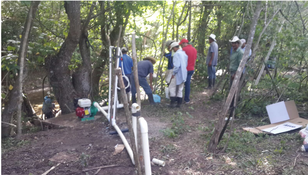
Figura 39. Instalación de tubería
