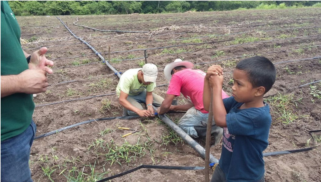
Figura 35. Instalación de sistema de riego
