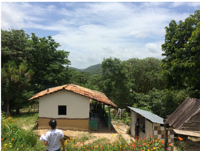
Figura 32. Vivienda de El Cantón
