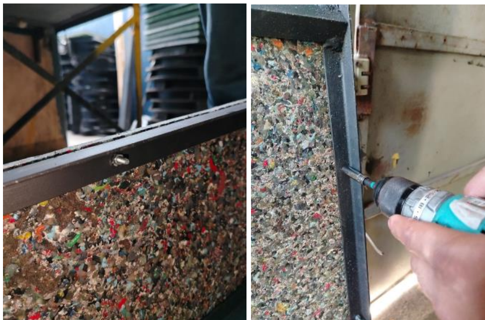
ANEXO 13 -AJUSTE DE TUERCAS PARA ASEGURAR LA TABLA A LA ESTRUCTURA METÁLICA
