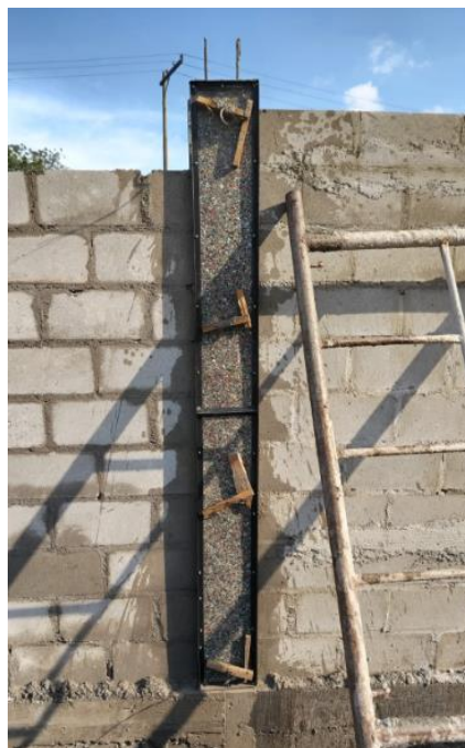
ANEXO 23 -ENCOFRADO DE CASTILLO COLOCADO Y SUJETO CON BOLILLOS
