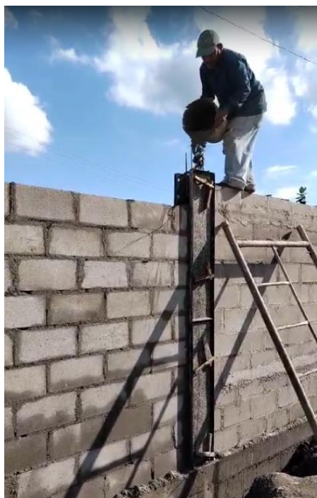
ANEXO 24 -VERTIDO DE CONCRETO EN ENCOFRADO DE PLÁSTICO PARA CASTILLO
