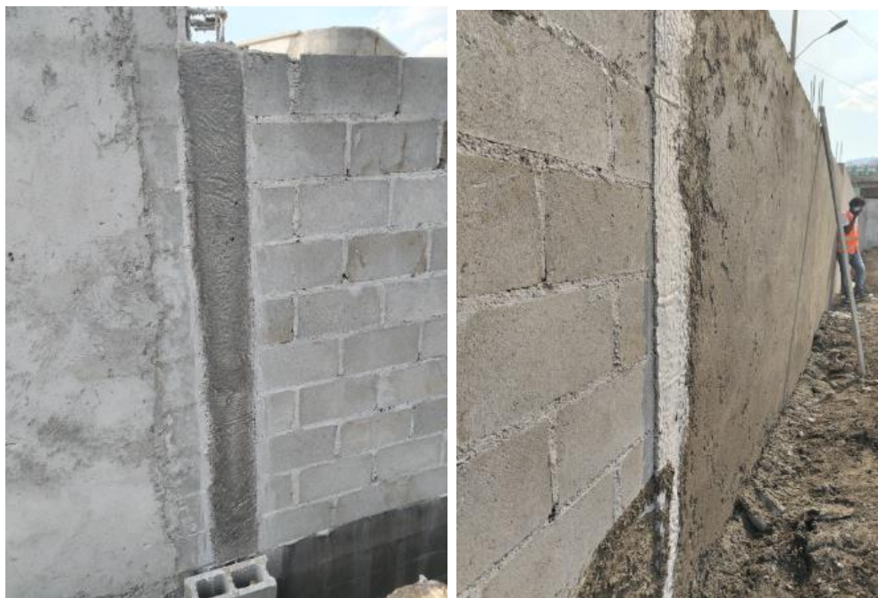
ANEXO 25 -ACABADO FINAL DE CASTILLO Y PROCESO DE REPELLO
