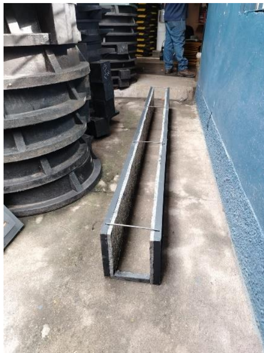
ANEXO 17 -SISTEMA DE ENCOFRADO DE SOLERA CON VARILLAS DE ¼" COMO SEPARADORES
