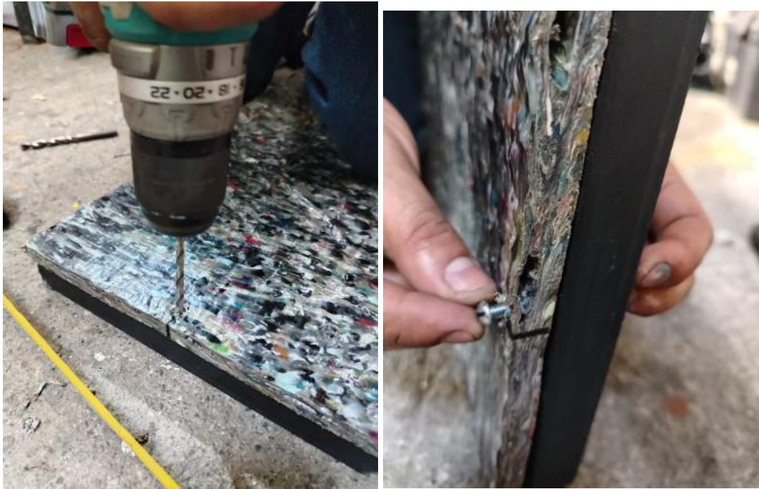
ANEXO 12 -PERFORACIÓN DE TABLA Y ÁNGULO PARA COLOCACIÓN DE PERNOS DE ANCLAJE DE 3/16" x 1 1/2"
