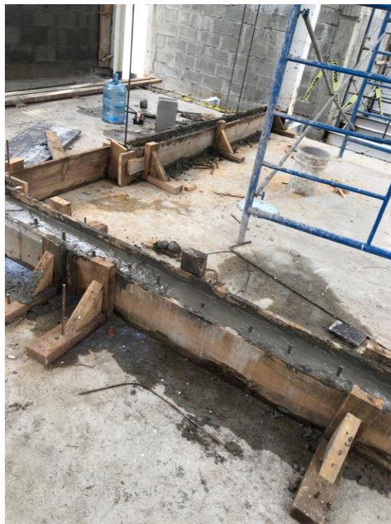
ILUSTRACIÓN 8 -CONSTRUCCIÓN DE SOLERA INFERIOR
