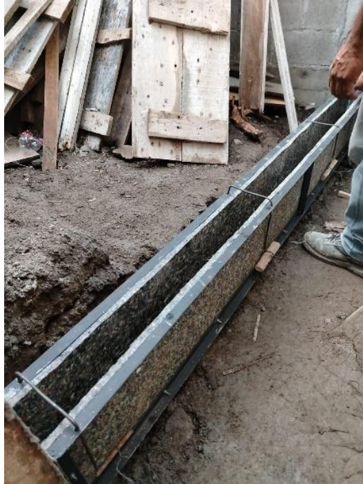
ANEXO 18 -SISTEMA DE ENCOFRADO DE PLÁSTICO RECICLADO DE SOLERA EN SITIO AJUSTADO CON SEPARADORES DE VARILLA Y BOLILLOS
