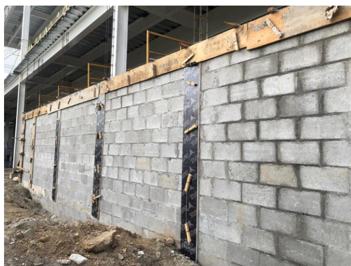
ILUSTRACIÓN 6 – ENCOFRADO DE CASTILLOS CON BOLILLOS
