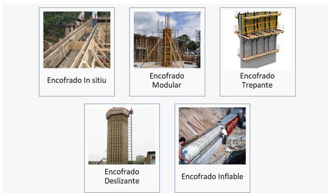
ILUSTRACIÓN 4 –CLASIFICACIÓN DE LOS SISTEMAS DE ENCOFRADO
