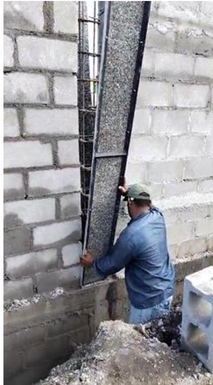
ANEXO 22 -COLOCACIÓN DE ENCOFRADO PARA CASTILLO DE 20CM DE ANCHO Y 220CM DE ALTO
