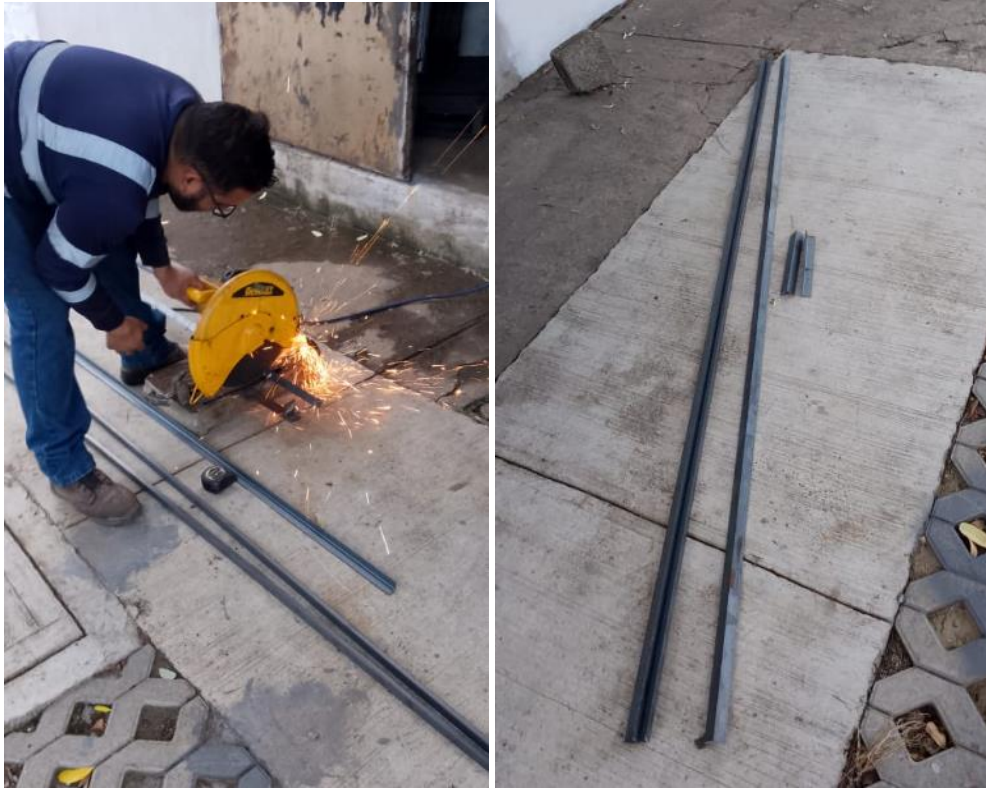
ANEXO 8 -CORTE DE ÁNGULO METÁLICO DE 1"x1"x1/8" PARA ESTRUCTURA DEL SISTEMA DE ENCOFRADO PLÁSTICO
