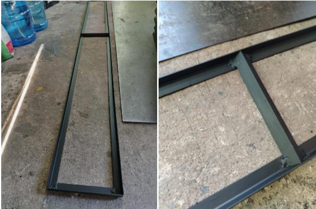
ANEXO 10 -PINTADO DE ESTRUCTURA CON PINTURA ANTICORROSIVA NEGRA
