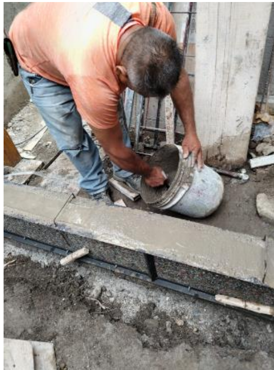
ANEXO 19 -VERTIDO DE CONCRETO EN ENCOFRADO DE PLÁSTICO PARA SOLERA
