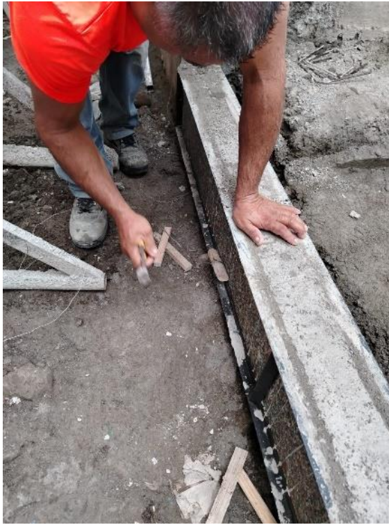
ANEXO 20 -DESENCOFRADO DE SOLERA
