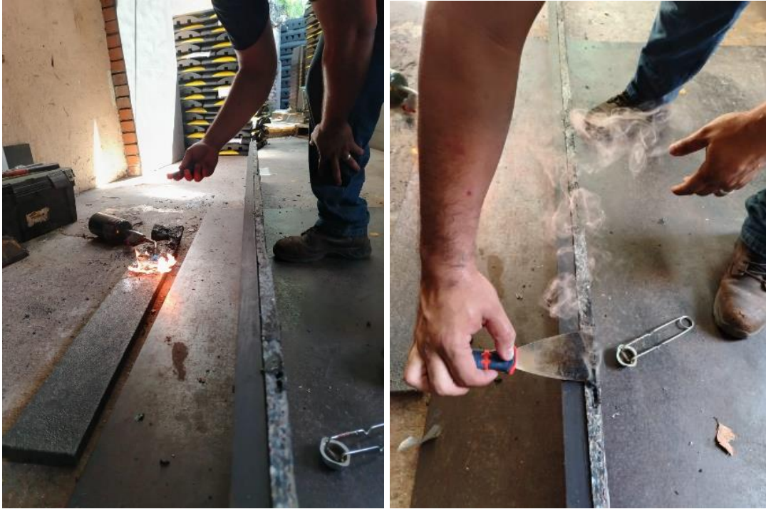
ANEXO 14 -SELLADO DE HUECOS CON POLIETILENO RECICLADO
