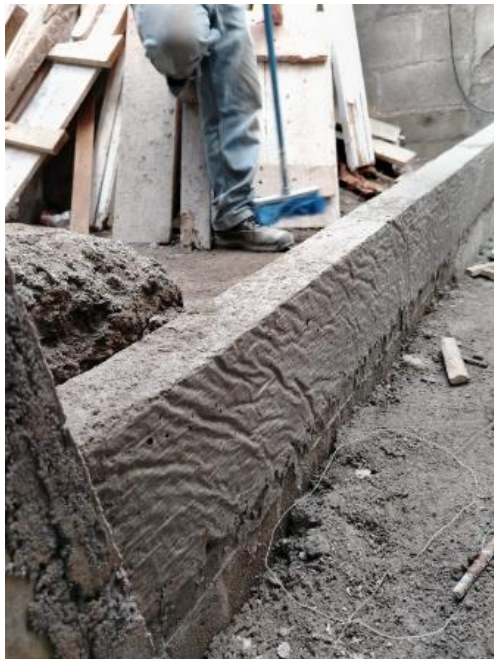
ANEXO 21 -ACABADO FINAL DE SOLERA SOBRE BLOQUE DE 4" CON 20CM DE ALTO
