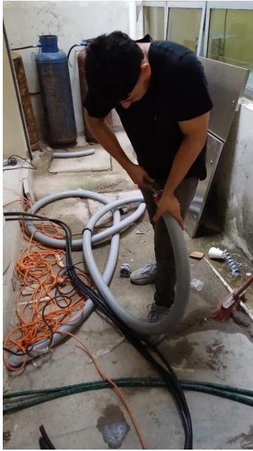
Anexo 31. Instalación de Autoclave
