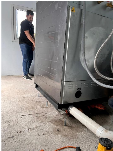
Anexo 14. Instalación de Lavadora Industrial
