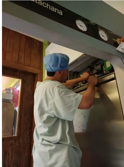
Anexo 29. Instalación de Autoclave
