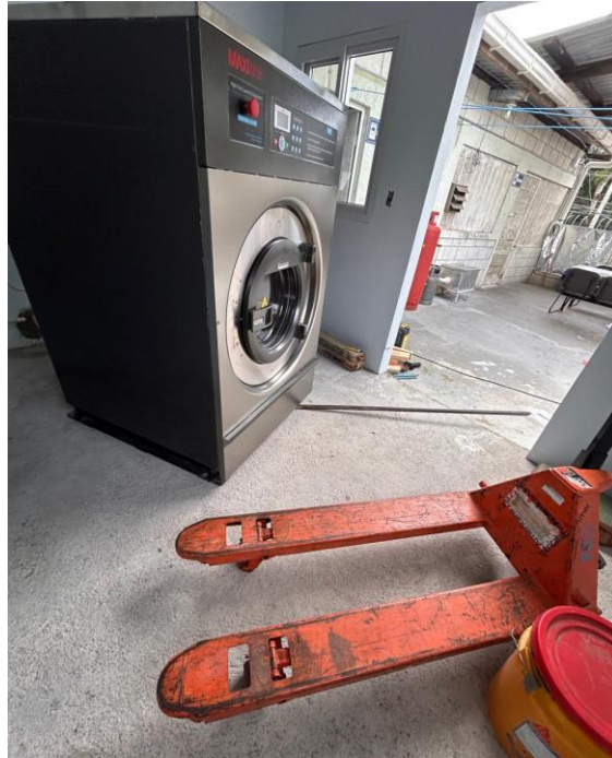
Anexo 13. Instalación de Lavadora Industrial
