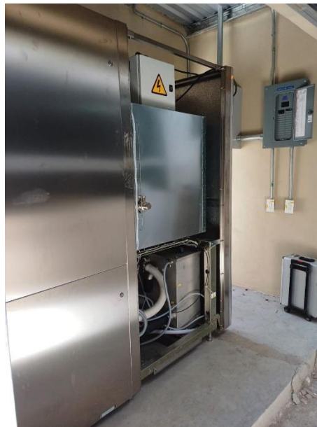
Anexo 30. Instalación de Autoclave
