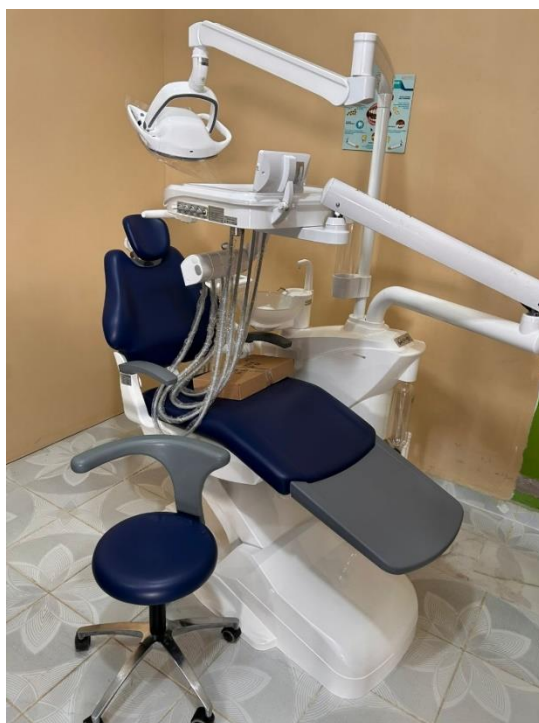
Anexo 64. Instalación de Unidad Odontológica
