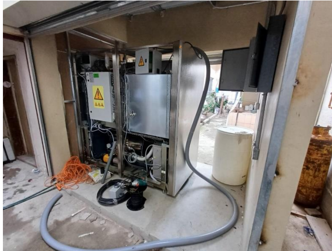
Anexo 33. Instalación de Autoclave
