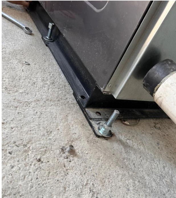
Anexo 15. Instalación de tornillos de seguridad para Lavadora Industrial
