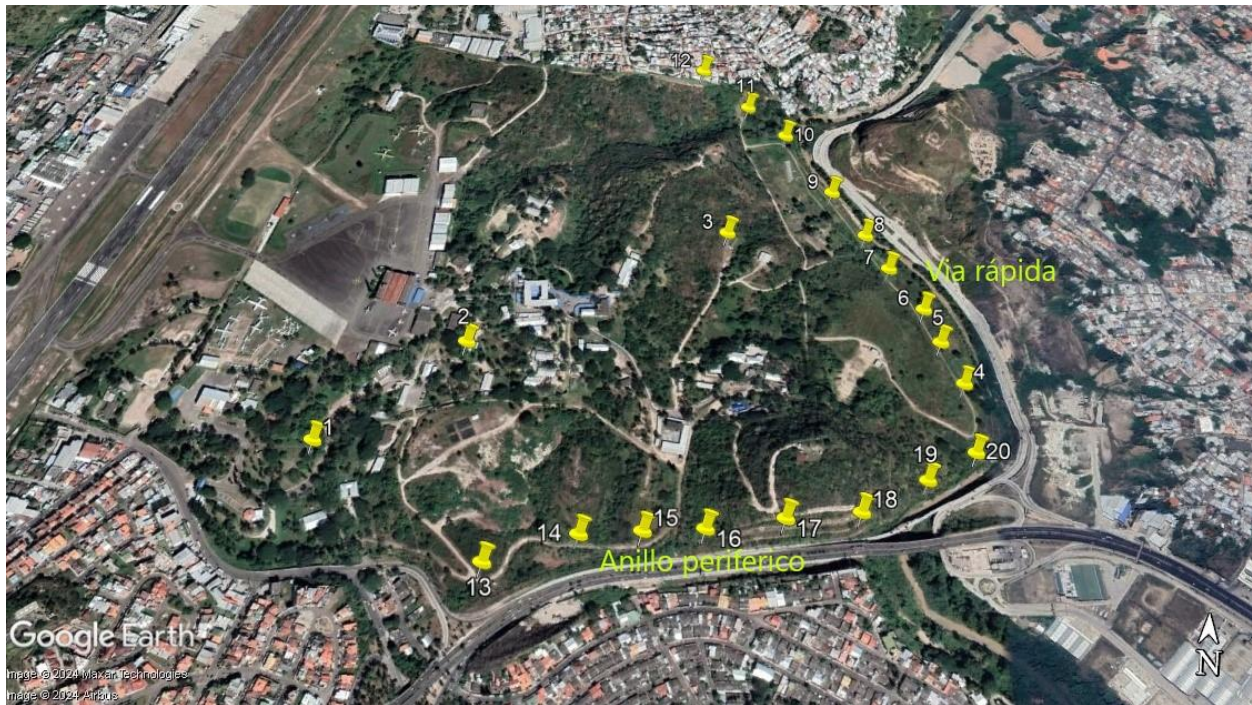
Figura 1. Puntos en los que se instalará la primera fase de reflectores.
