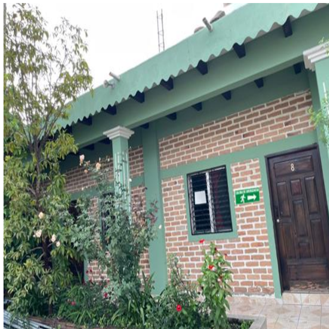
Ilustración 67: Señalización de salida de evacuación
