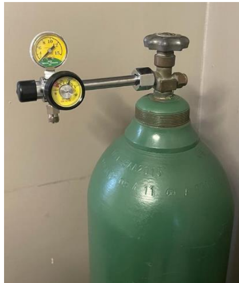
Ilustración 61: Instalación de manómetro en cilindro de oxígeno
