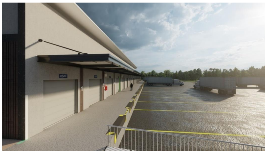
Vista exterior anden de carga y descarga
