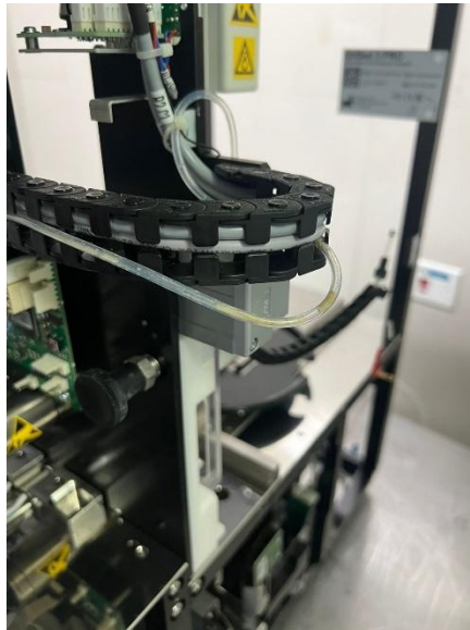
Ilustración 62: Mangueras obstruidas con sedimento urinario.
