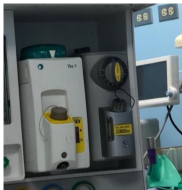
Ilustración 39. Pruebas de funcionamiento a vaporizadores
