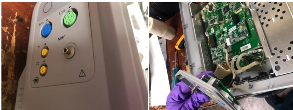
Ilustración 90. Mantenimiento a MSV de UCIA
