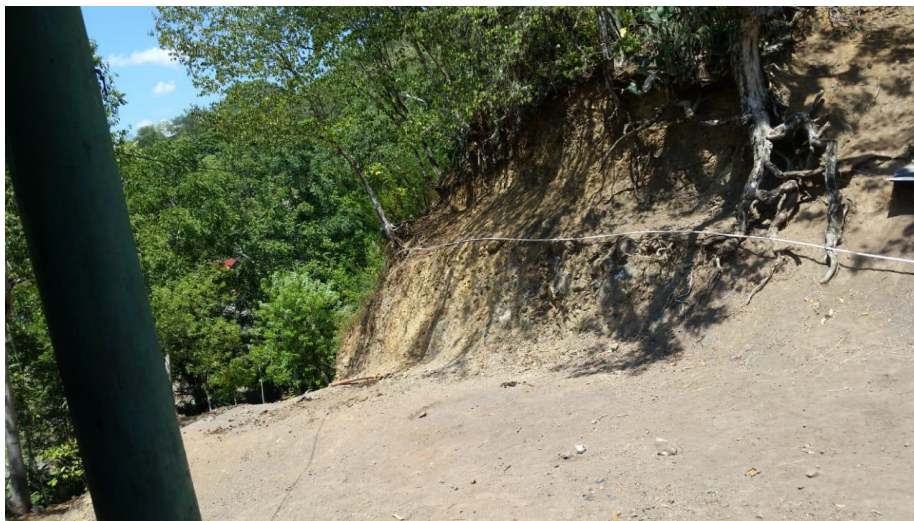
Ilustración 41. Tubería PVC expuesta a la intemperie
