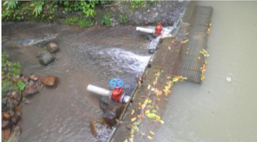
Ilustración 2-Obra de captación terminada
