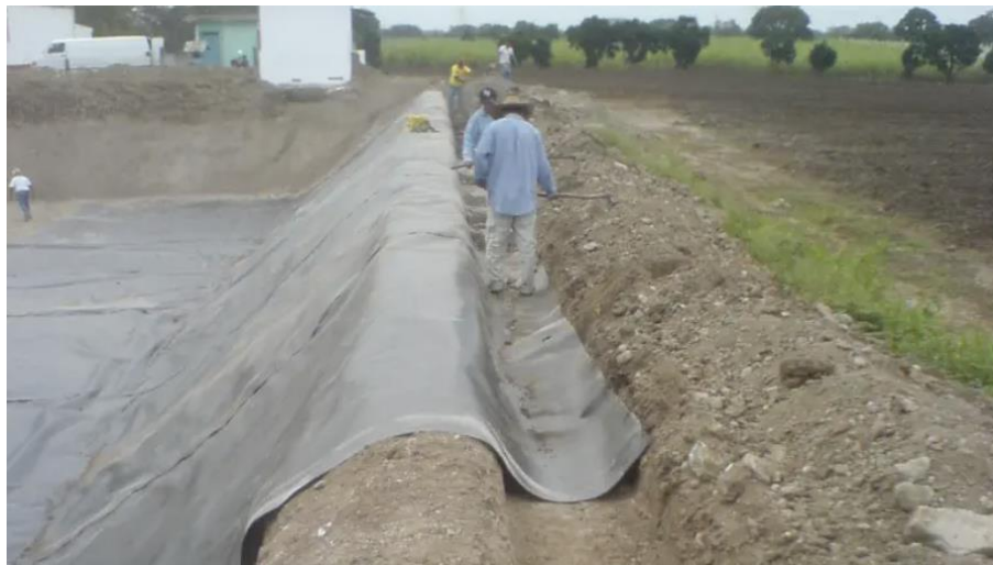
Ilustración 9. Trinchera en donde se coloca la geomembrana para posteriormente cubrirla con el mismo material producto de la excavación y sujetar de esta manera la geomembrana.
