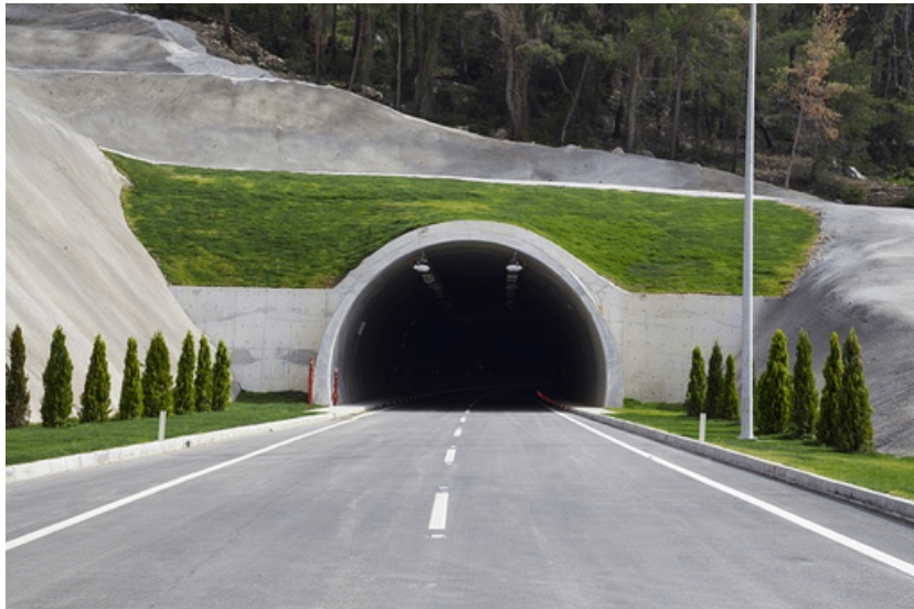
Ilustración 57 - Efecto de "agujero negro" en la entrada de un túnel largo
