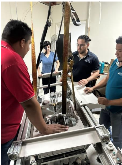
Ilustración 46. Instalación de rieles cielíticos de la fluoroscopia
