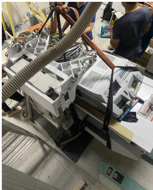
Ilustración 48. Instalación de fluoroscopia GE
