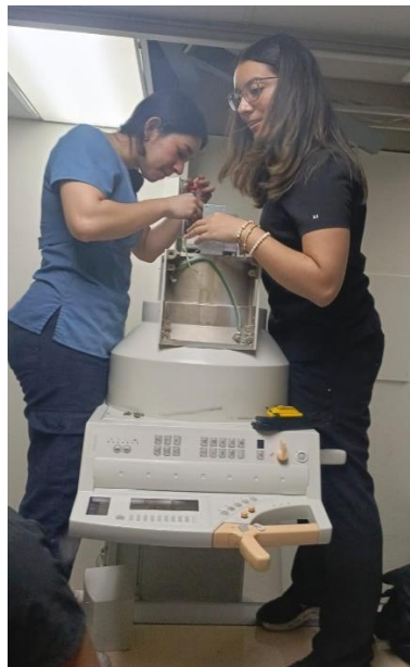
Ilustración 30. Desinstalación de fluoroscopia en Hospital del Valle
