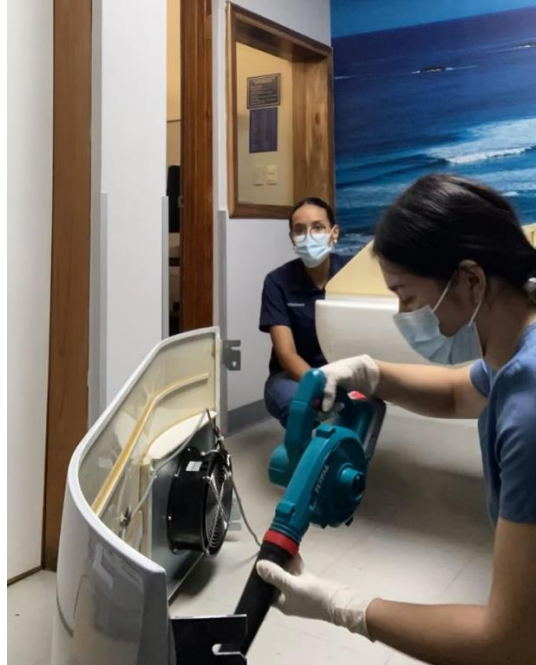
Ilustración 54. Mantenimiento de carcasa del equipo
