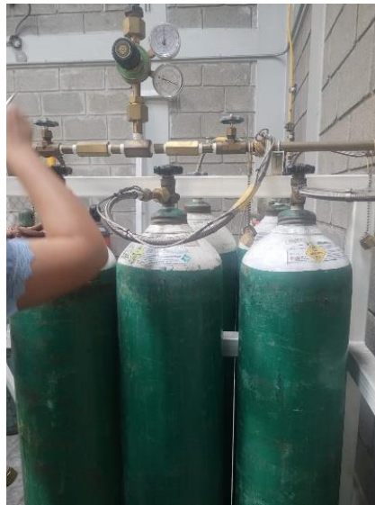
Ilustración 49: Cambio de cilindros de oxigeno
