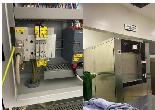
Ilustración 59- Restablecimiento de las microválvulas de la autoclave.
