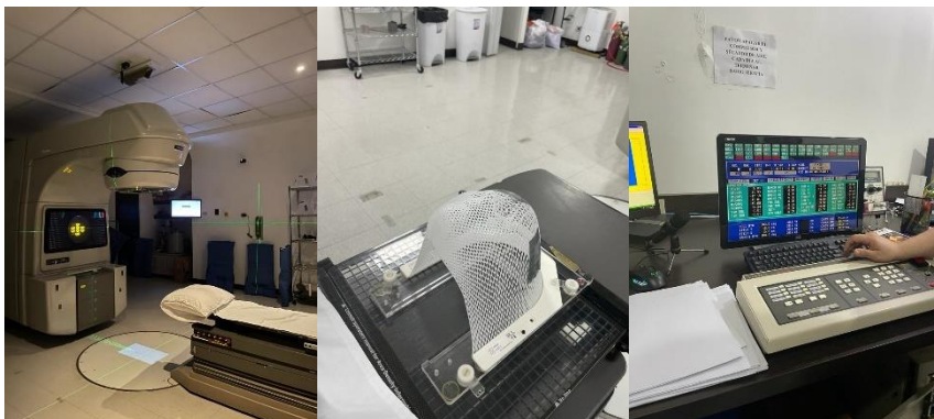
Ilustración 57- Inspección visual del acelerador lineal del Hospital Bendaña.
