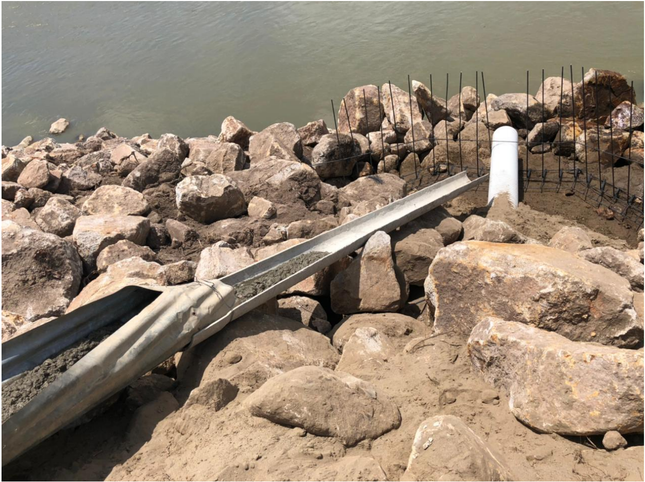
Figura 7. Aterrado de tubería
