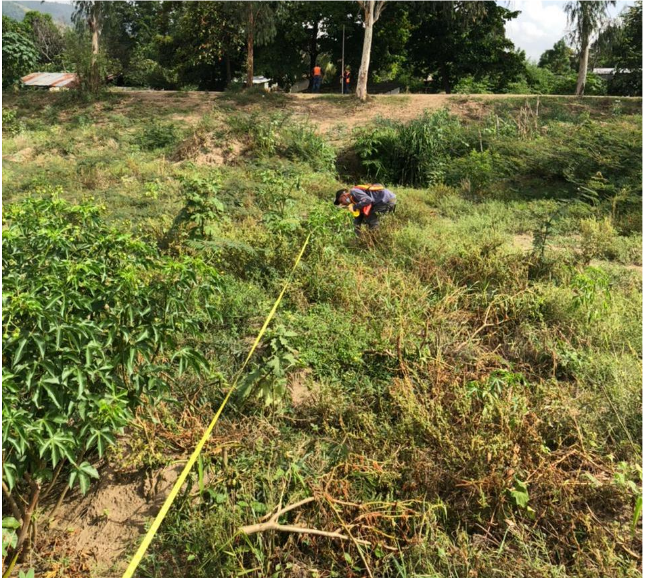
Figura 4. Medición para instalación de una tubería
