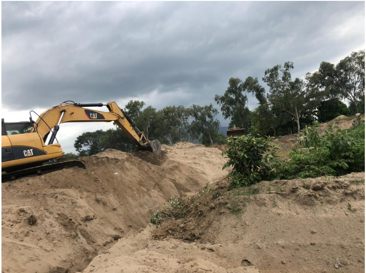
Figura 13. Excavación de material para su respectivo acarreo
