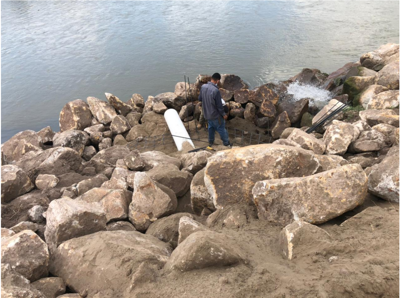
Figura 5. Colocación de tubería novafort
