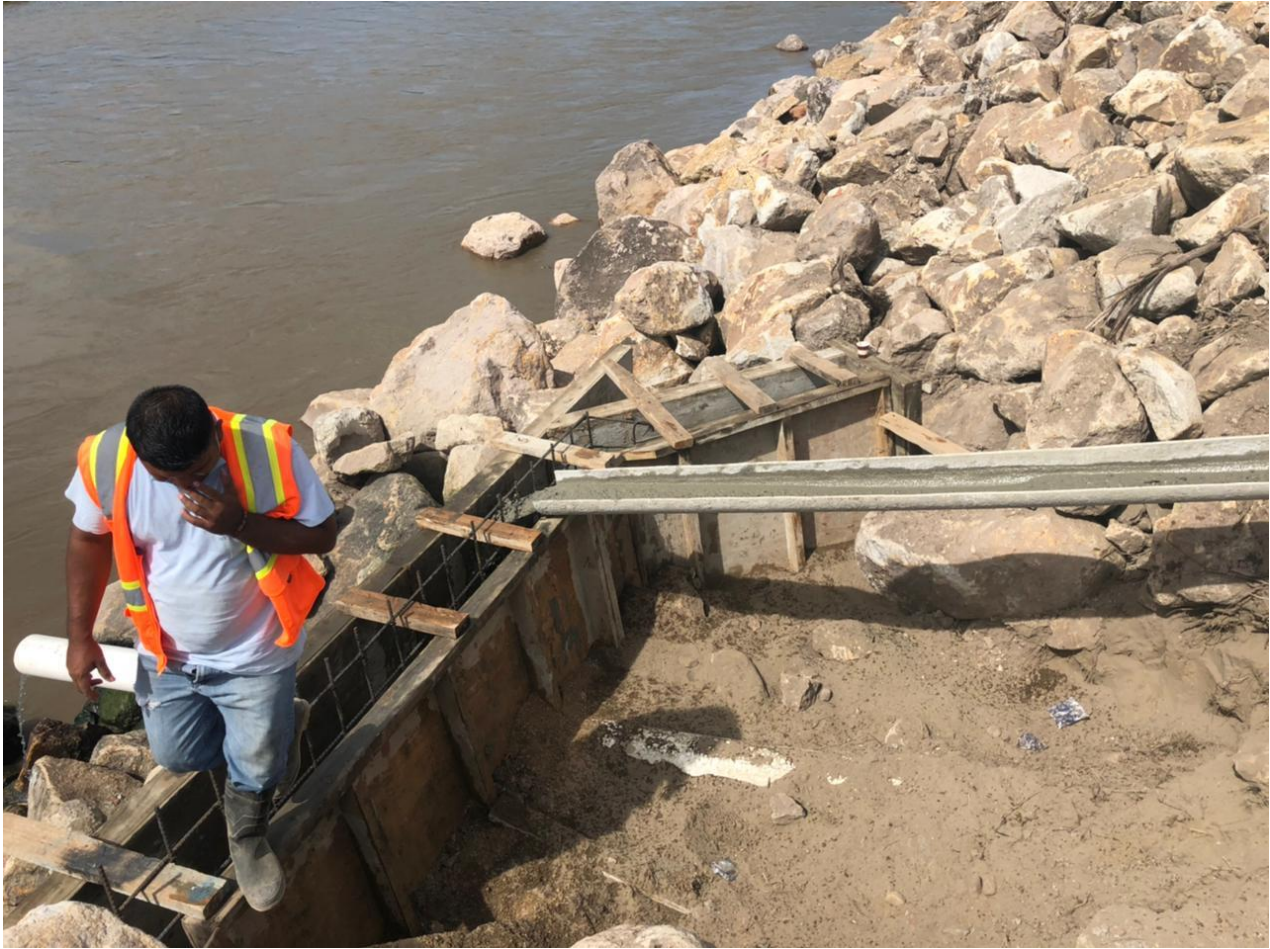
Figura 8. Fundición para tubería
