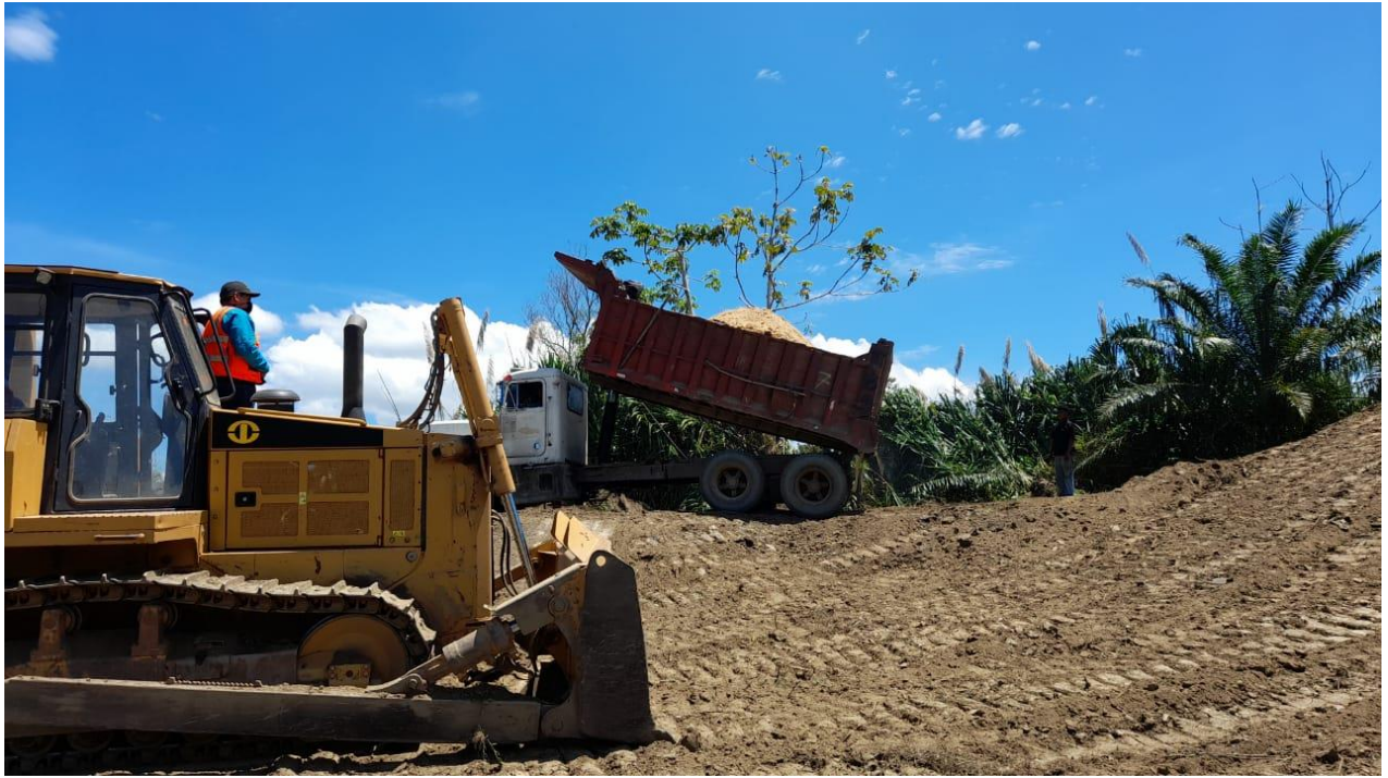
Figura 10. Compactado de terreno
