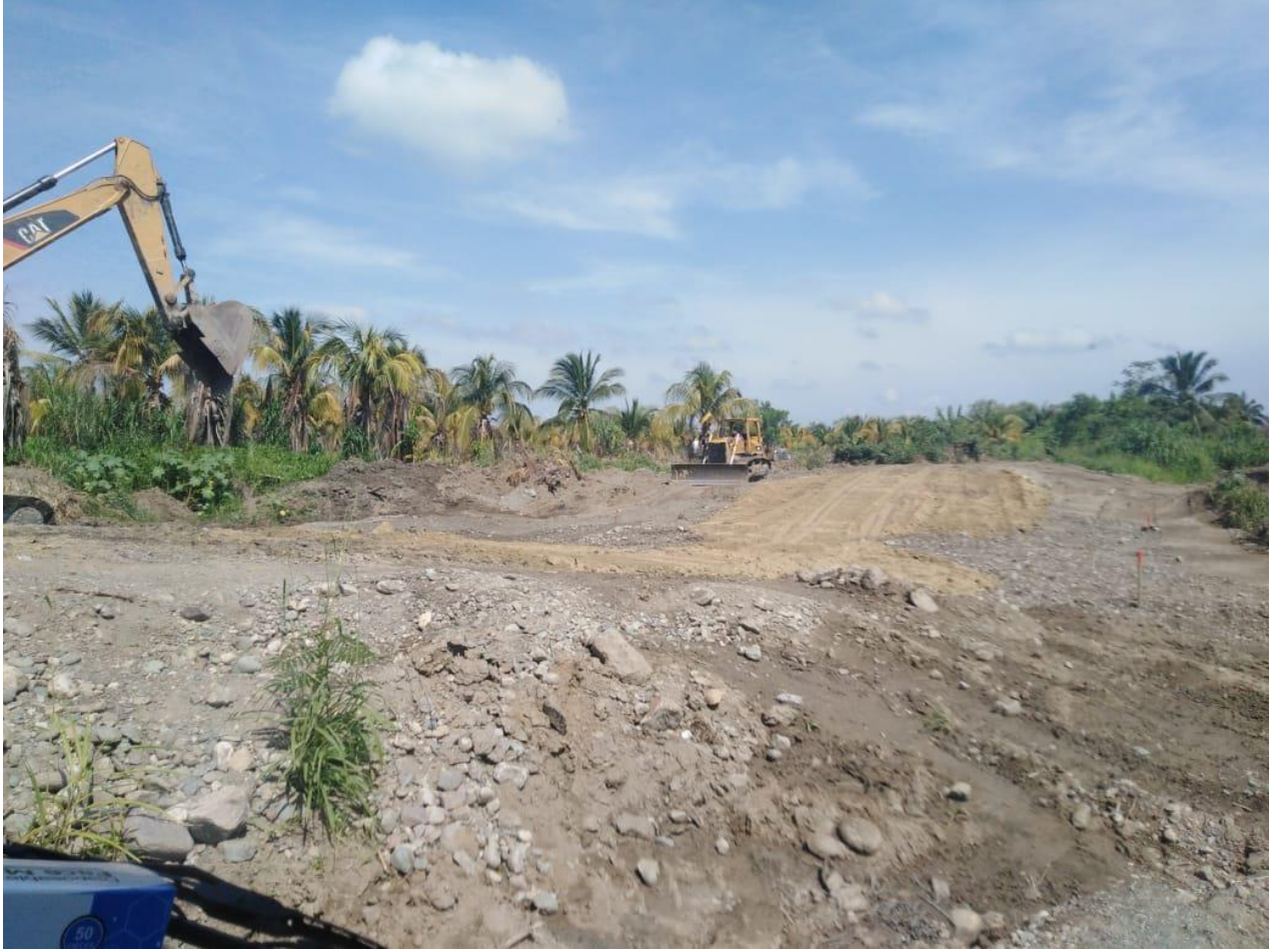
Figura 9. Reconstrucción del margen izquierdo del Rio Guaymon
