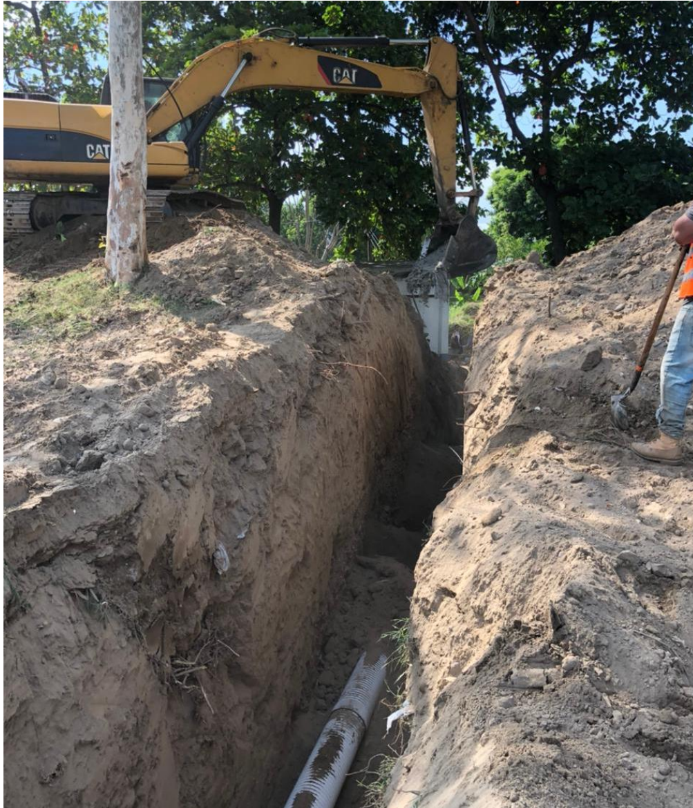
Figura 11. Instalación de tubería
