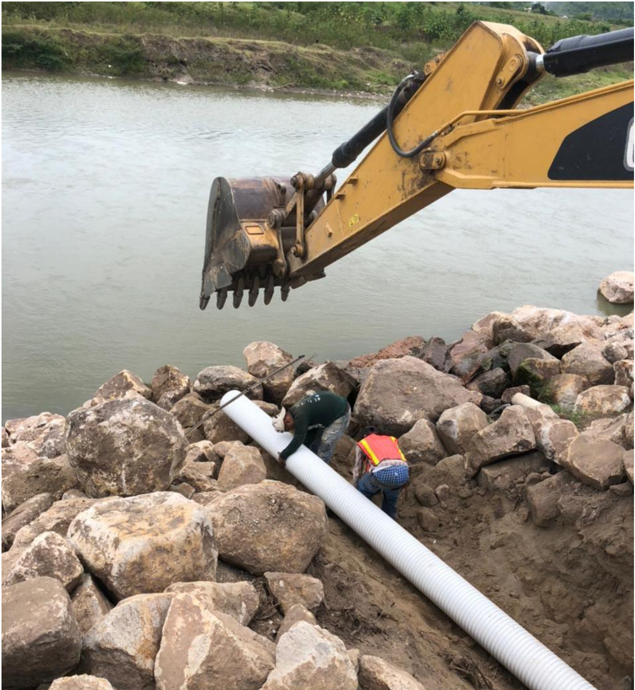
Figura 6. Colocación de tubería en el río Chamelecón
