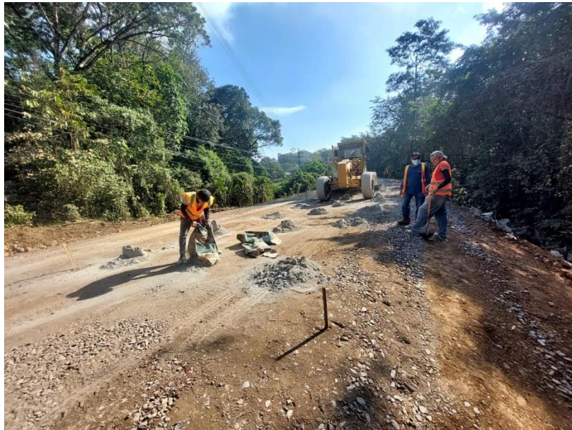
Ilustración 5-colocación bolsas de cemento
