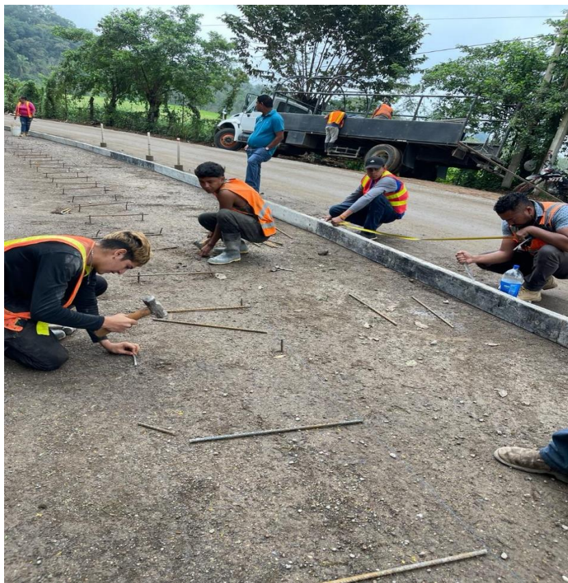
Ilustración 3-encofrado y armado de hierro
