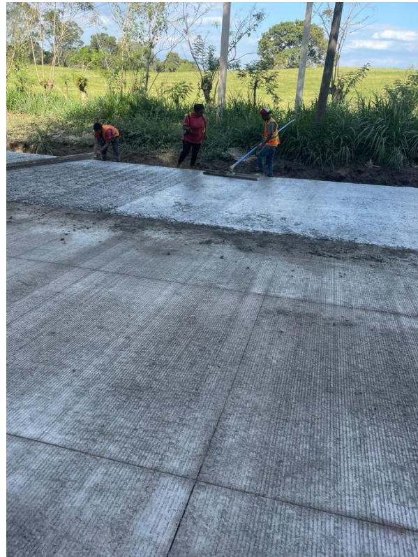
Ilustración 11-Acabado del concreto
