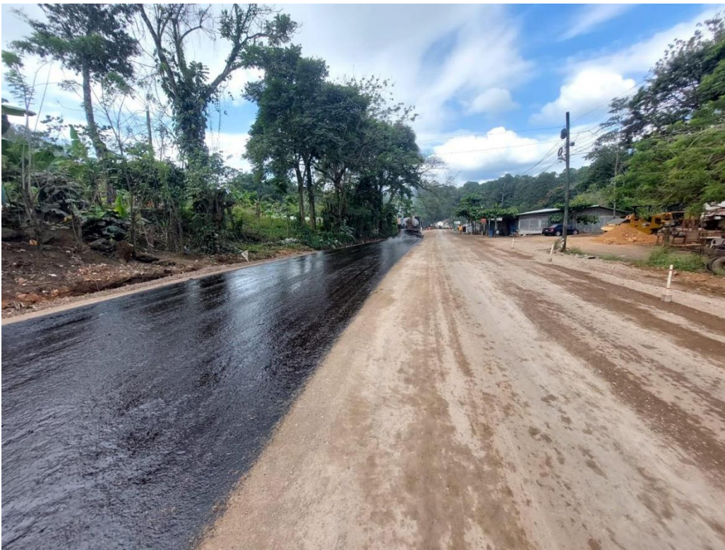
Ilustración 7-riego de imprimación asfáltica
