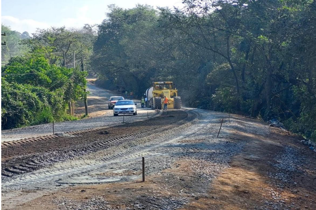
Ilustración 6-recicladora mezclando suelo cemento
