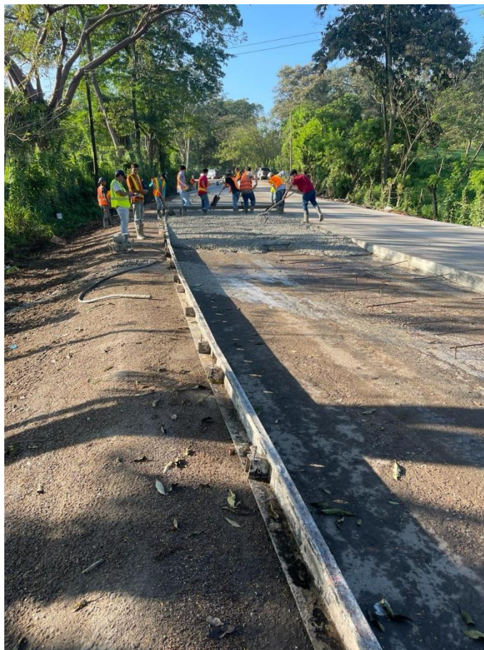
Ilustración 9-fundición de concreto
