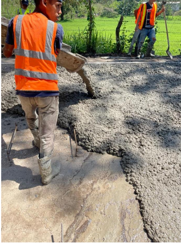
Ilustración 2-vertido de mezcla de concreto
