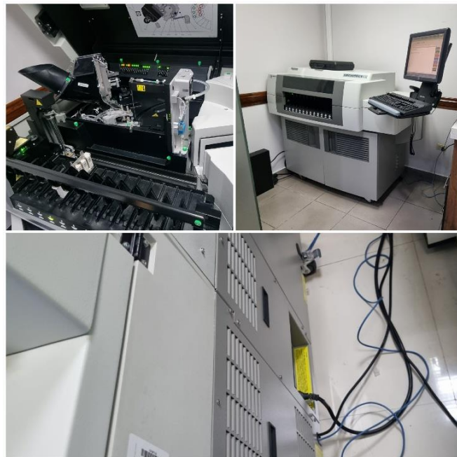
Ilustración 35 - Instalación de i1000SR en HDV.
