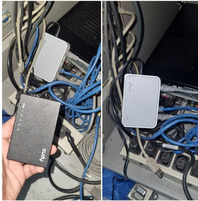
Ilustración 34 - Cambio de Puerto Swith en HB.
