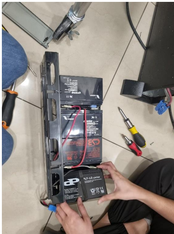
Ilustración 45 - Cambio de baterías en UPS.
