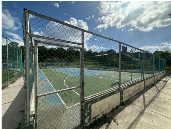
Ilustración 143 Cancha Multipropósito de Concreto, Imagen Propia
