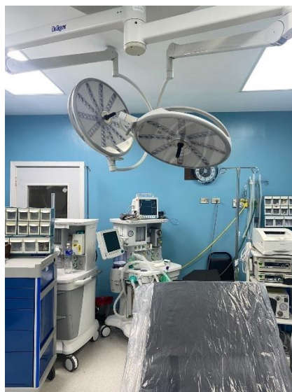
Anexo 16. Visita al Hospital Mario Catarino Rivas Sala Quirófano
