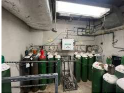
Ilustración 19- Manifold de oxígeno
