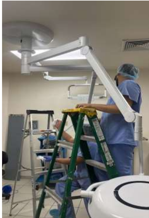
Ilustración 69- Ajuste de lámpara Quirúrgica
