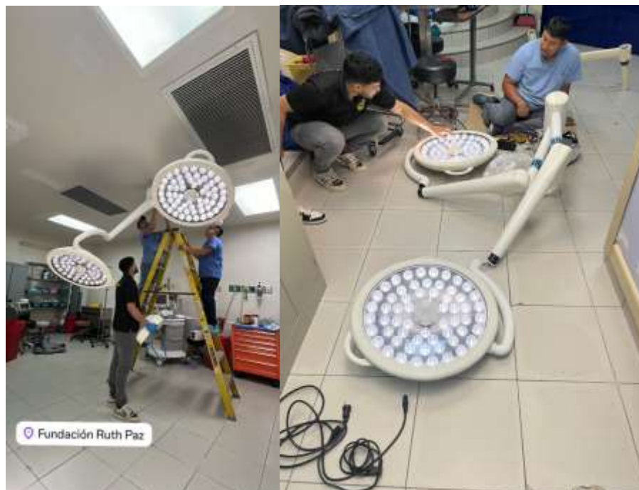
Ilustración 18- Instalación de lámpara quirúrgica
