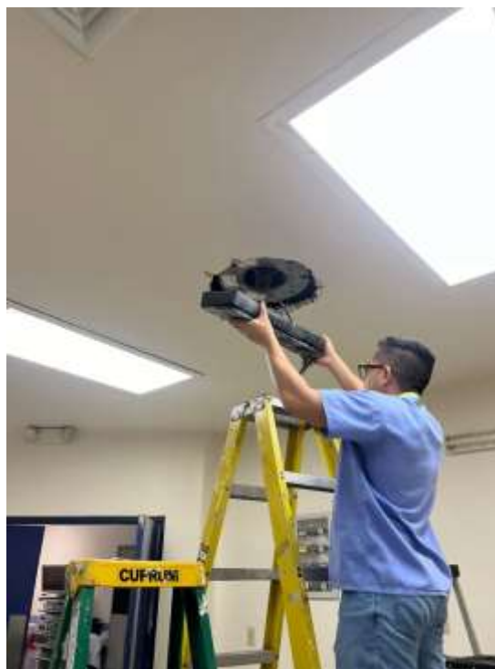
Anexos 2- Instalación de lámpara quirúrgica
