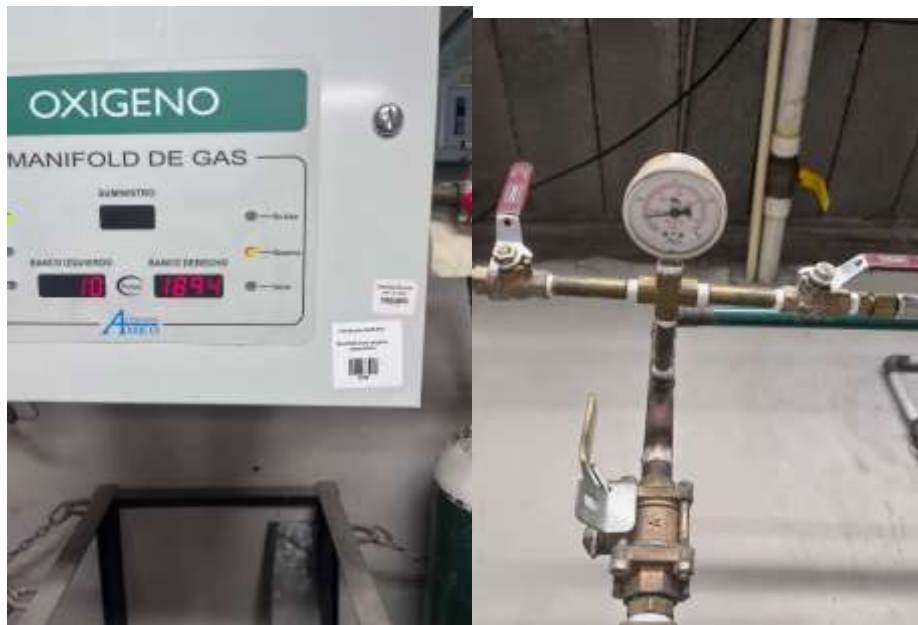
Ilustración 94- Verificación de parámetros de oxígeno
