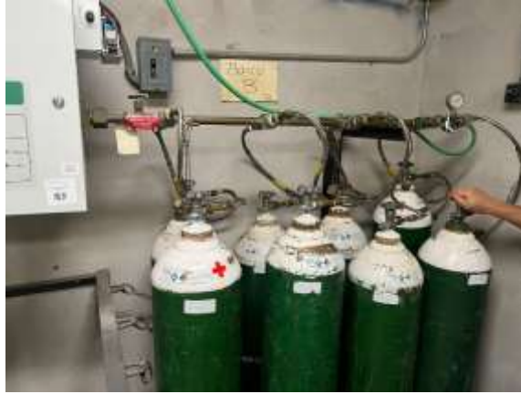
Ilustración 13- Manifold Oxígeno
