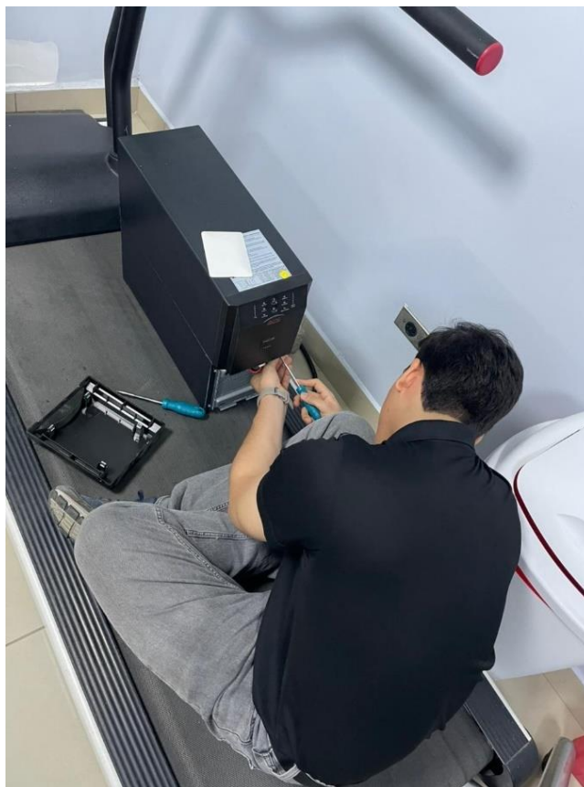
Ilustración 38: Cambio de baterías a UPS
