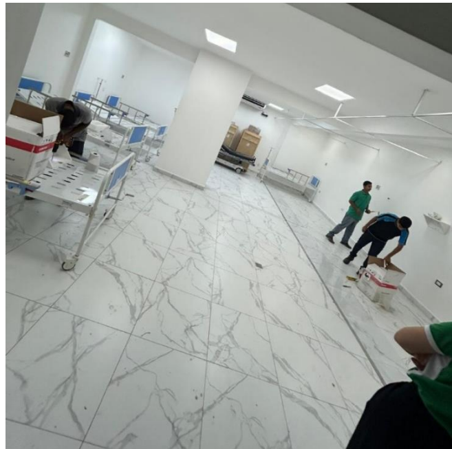
Ilustración 33: Instalación de MSV
