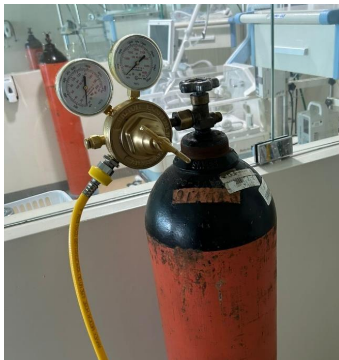
Ilustración 24: Reguladores nuevos de aire comprimido
