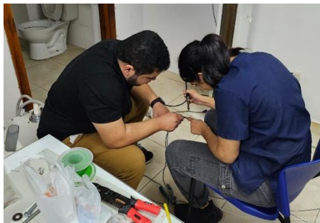
Ilustración 51 - Realizando la extensión de los cables
