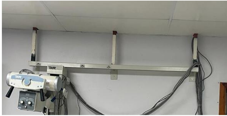
Ilustración 50 – Proceso de soldadura terminado
