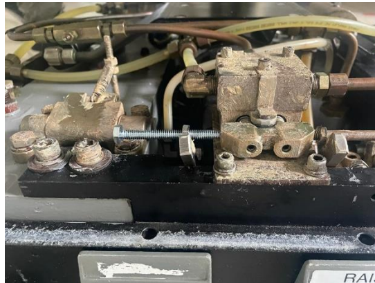
Ilustración 74 - Reemplazo de la pieza quebrada
