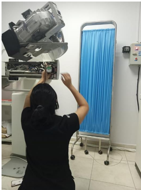
Ilustración 67 - Instalación del nuevo motor
