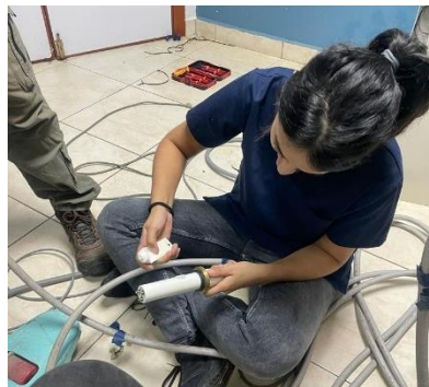
Ilustración 54 - Colocación de la grasa a los tubos de alto voltaje
