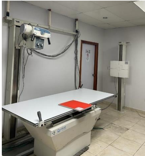
Ilustración 58 - Instalación de rayos X estacionario-completada
