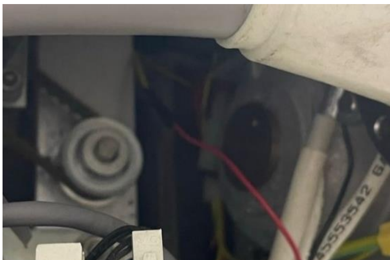
Ilustración 25 - Colocación de la cinta aislante
