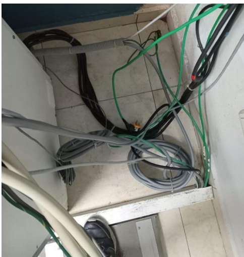
Ilustración 29- Después de la limpieza
