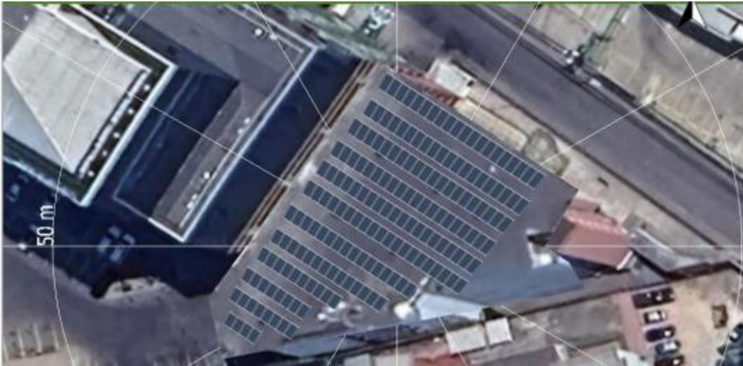
Imagen 6.5 Vista general del sistema fotovoltaico (Fuente: Flores y Flores Ingeniería)
