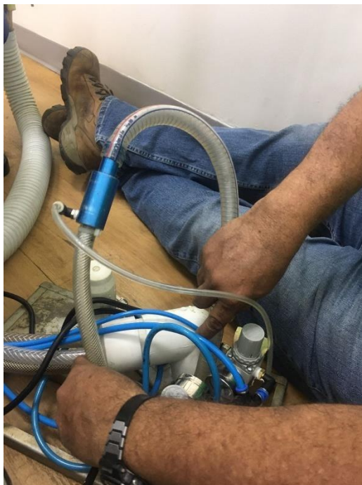
Ilustración 21-Sistema de drenaje de unidades odontológicas
