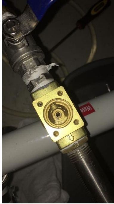
Ilustración 32-Electroválvula de entrada de agua
