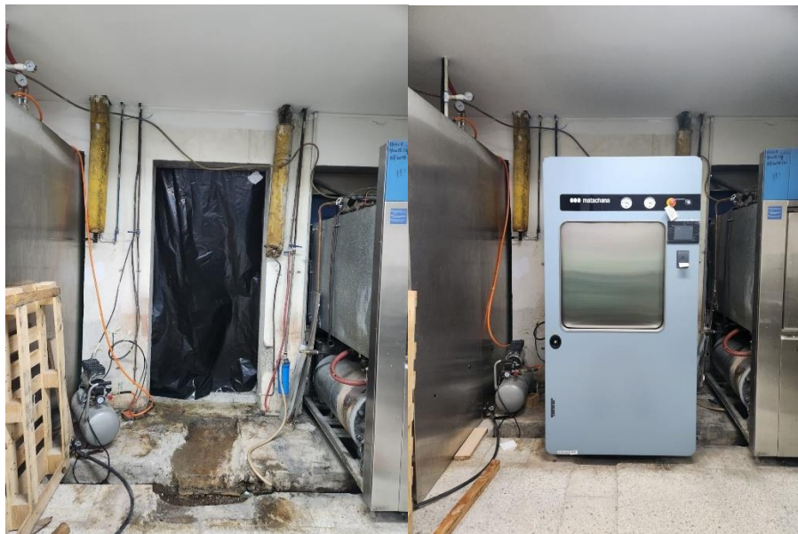
Ilustración 28. Espacio de instalación del autoclave Matachana.
