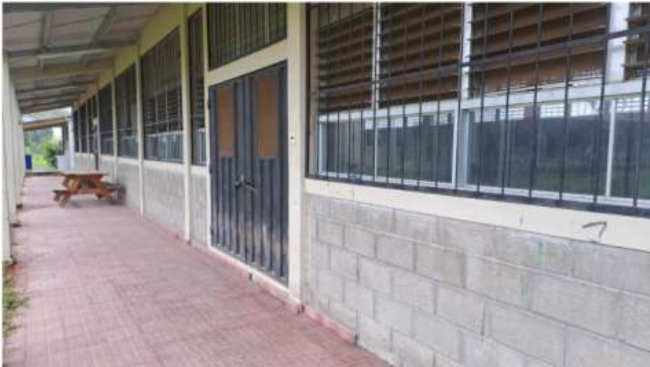
Figura 46. Aulas para los Talleres Vocacionales
