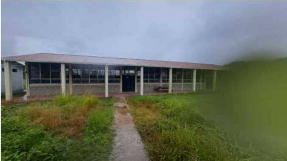
Figura 45. Aulas para los Talleres Vocacionales
