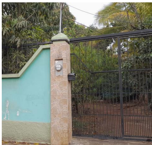
Figura 18 Medidor instalado en vivienda
