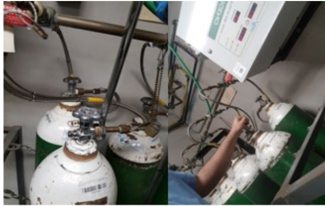
Ilustración 13 - Cambios de cilindros de oxígenos
