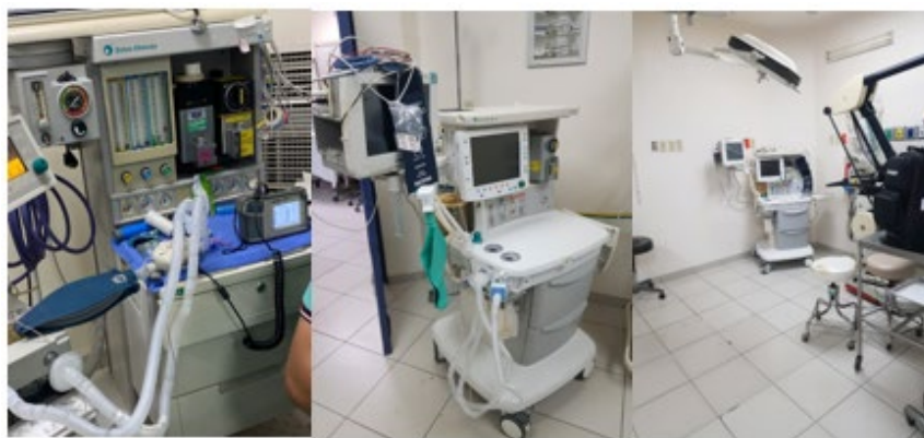
Ilustración 48 - Pruebas de funcionalidad de máquinas de anestesia y su posterior instalación
