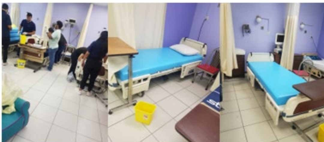
Ilustración 51 - Pruebas de funcionamiento e instalación de camas hospitalarias
