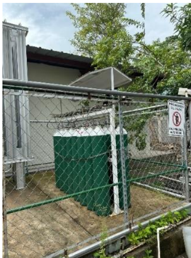
Ilustración 11 Manifold de respaldo.
