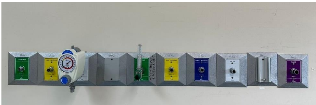
Ilustración 5 Tomas de gases medicinales.
