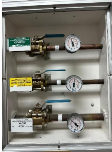
Ilustración 13 Caja de corte no acorde a normativa.
