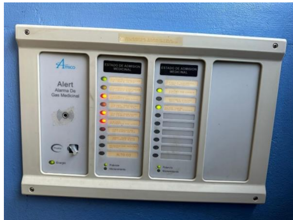
Ilustración 7 Alarma maestra del HMCR.
