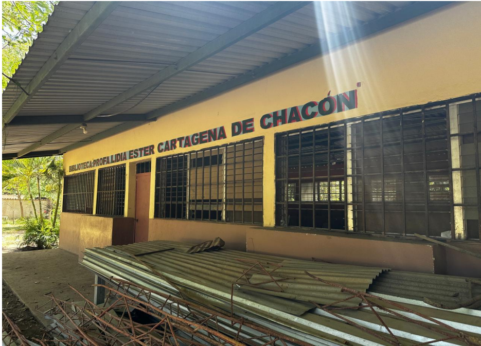
Figura 65 Fachada de Biblioteca
