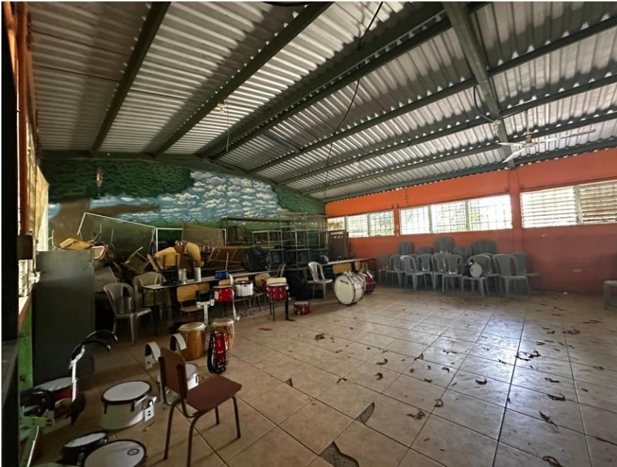
Figura 69 Estado Actual de biblioteca
