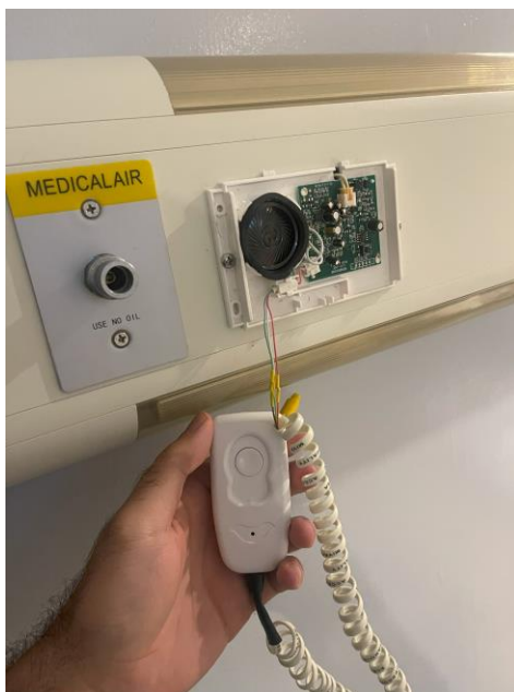
Ilustración 21 Instalación de controles
