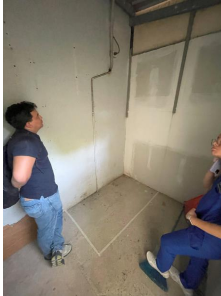
Ilustración 22 Levantamiento de campo para autoclave
