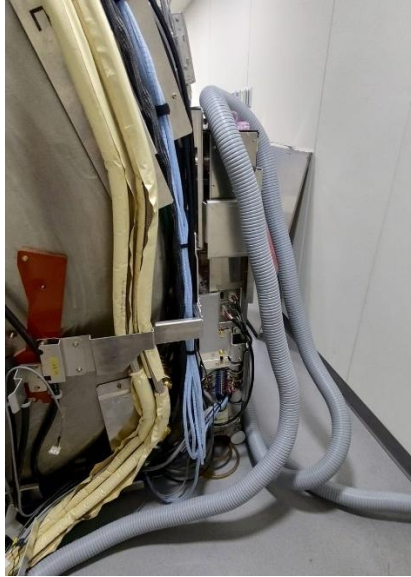
Ilustración 36 Instalación de Manguera de Ventilación.
