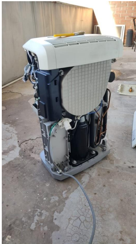
Ilustración 25 Mantenimiento Preventivo y correctivo a un deshumidificador.
