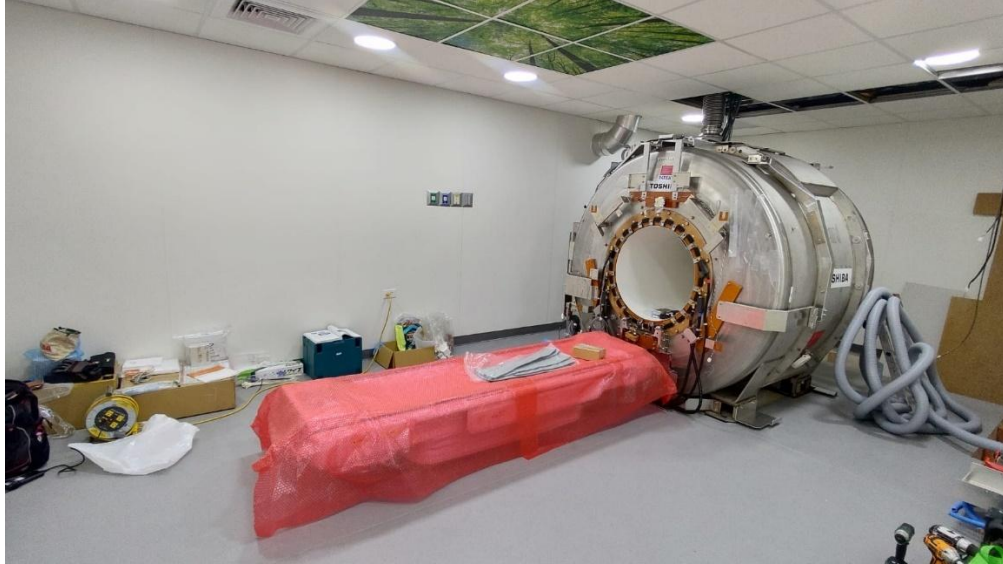
Ilustración 21 Instalación de mesa de MRI.
