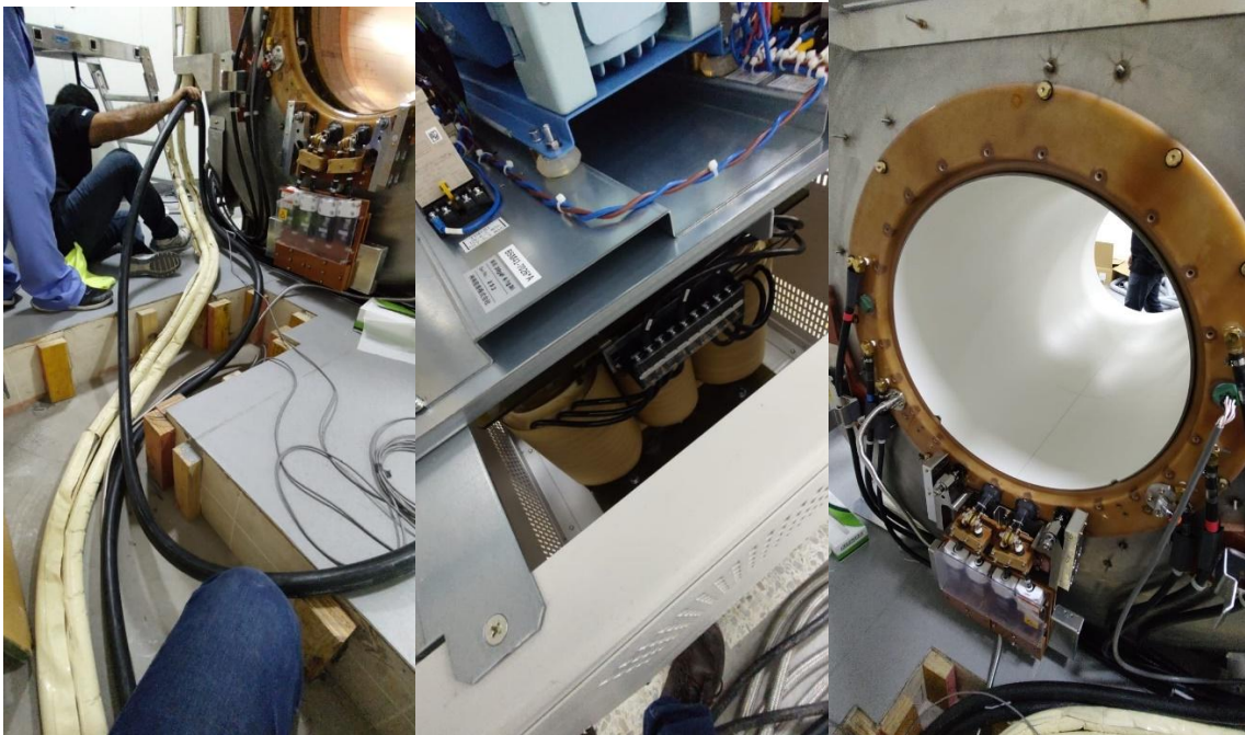
Ilustración 19 Sondeo de cables y avances de instalación en MRI.
