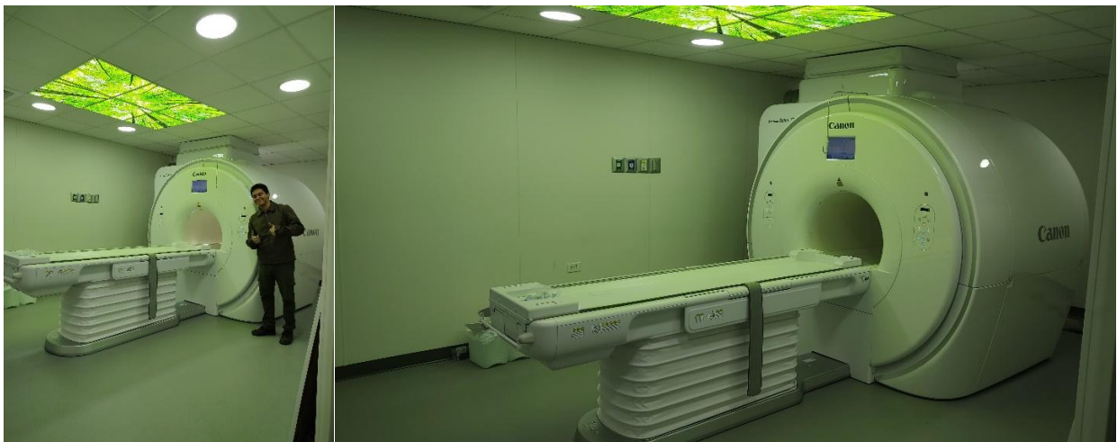
Ilustración 48 Instalación de covers y demás del Equipo de Resonancia Magnética completo.
