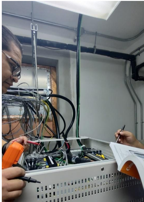
Ilustración 31 Comprobación de medición nominales de alto voltaje.
