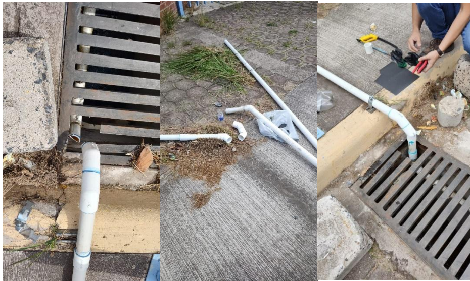
Ilustración 41 Reparación tubería Chiller de MRI.
