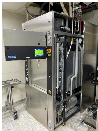
Ilustración 20: Autoclave Steris AMSCO 600
