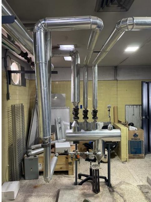
Anexo 1: Circuito de tuberías del esterilizador
