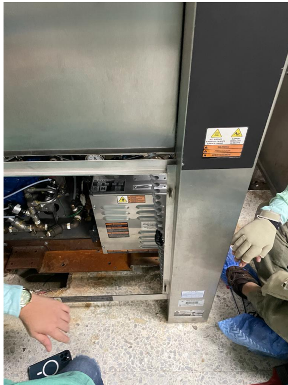
Ilustración 37: Cable de alimentación reparado y funcionando
