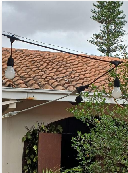
Figura 96. Fotografía - Iluminación Eléctrica Convencional. – Competencia No.2.
