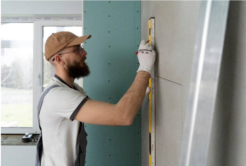
Figura 56. Imagen de paredes de tabla yeso.
